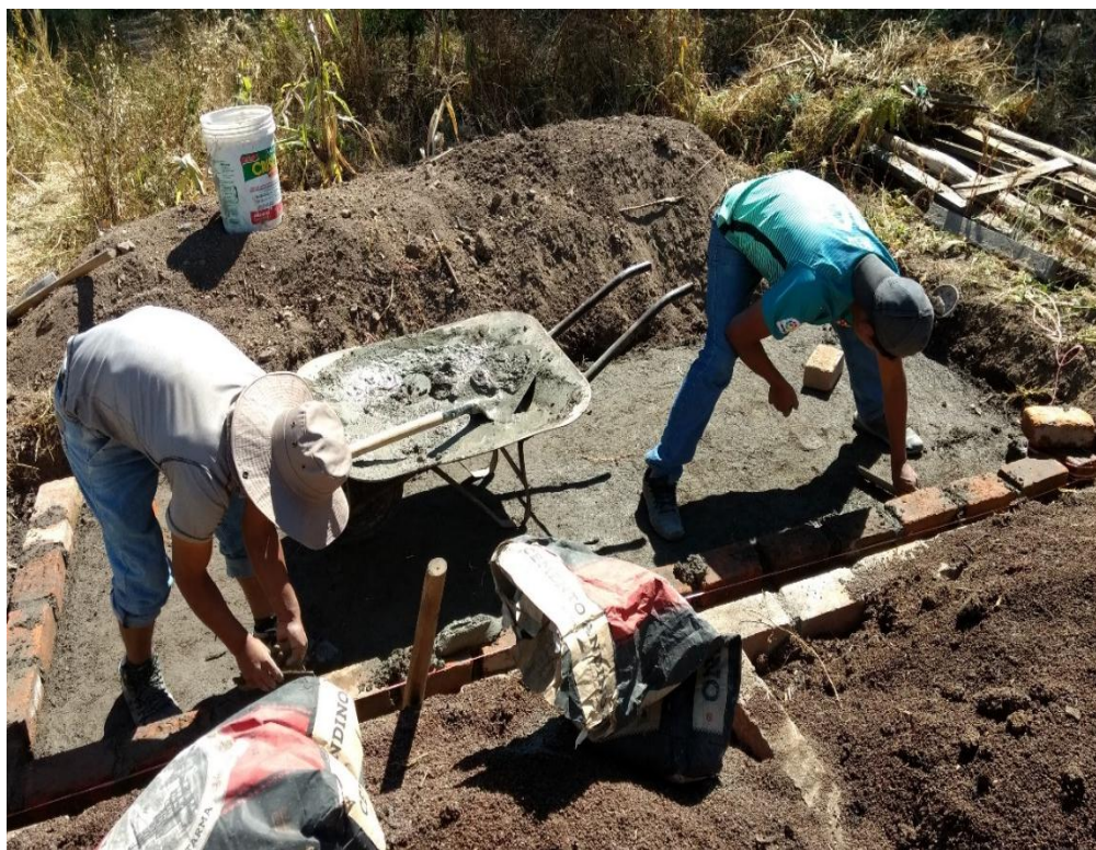
Foto 2.1. Construcción de pozas.
