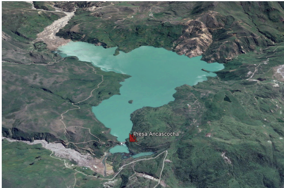
Figura 8 Ubicación de la presa Ancascocha Fuente: Obtenido de Google Earth
