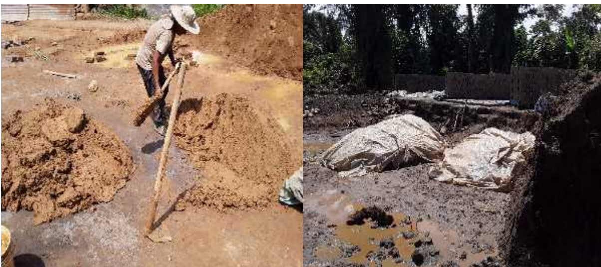
Figura 3.14: Obsérvese el amasado y reposo de la masa. Fuente: propia.
