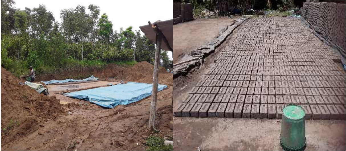
Figura 3.16: secado del ladrillo cubierto con plástico y el secado al aire libre. Fuente: propia.
