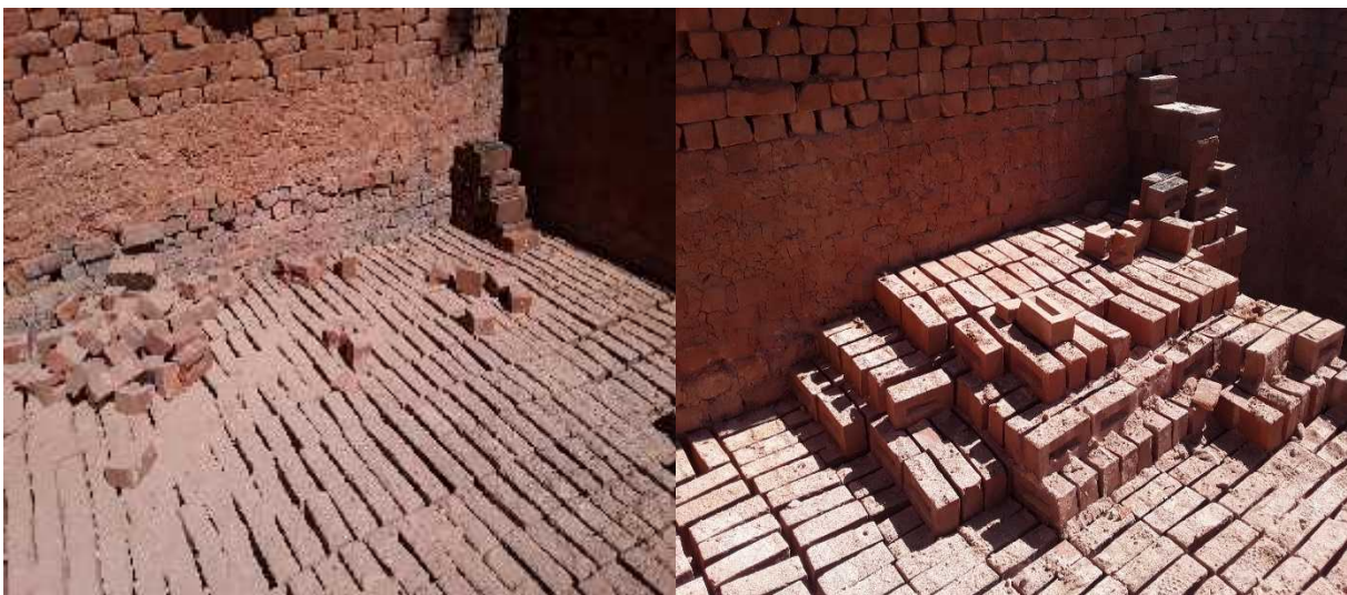
Figura 3.19: Abertura entre ladrillos y disposición de ladrillos en el horno. Fuente: propia
