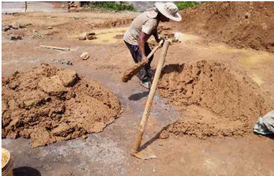
Figura 2.3: Amasado manual de la Masa. Fuente propia.
