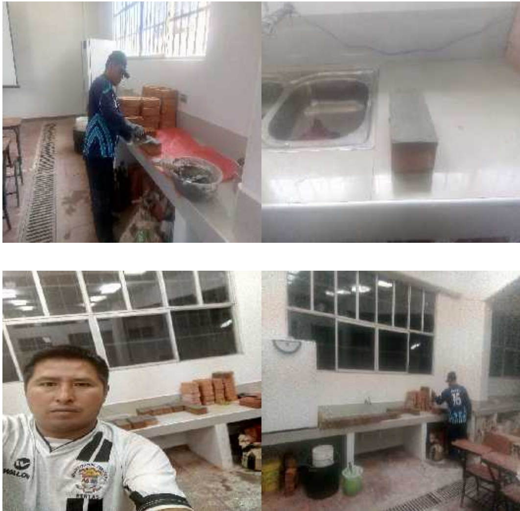
Figura 3.14: Muestra el Proceso de Refrentado de Capping en las Unidades de Albañilería. Fuente propia.
