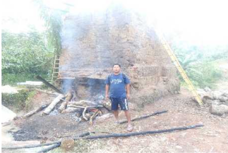
Figura 2.6: Quemado de los Ladrillos en un Horno Tradicional. Fuente propia.
