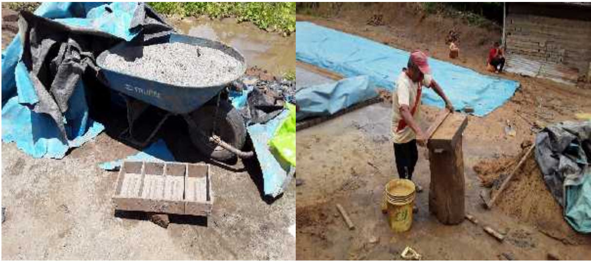
Figura 3.15: Obsérvese la gavera arenada y el enrasado de la gavera. Fuente: propia.
