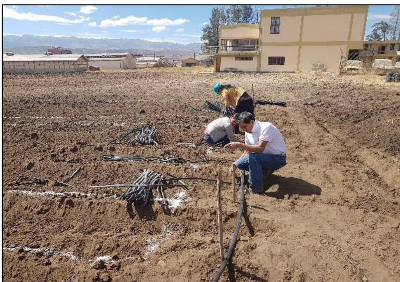
**Figura 2.8.** Instalación del sistema de riego por goteo
