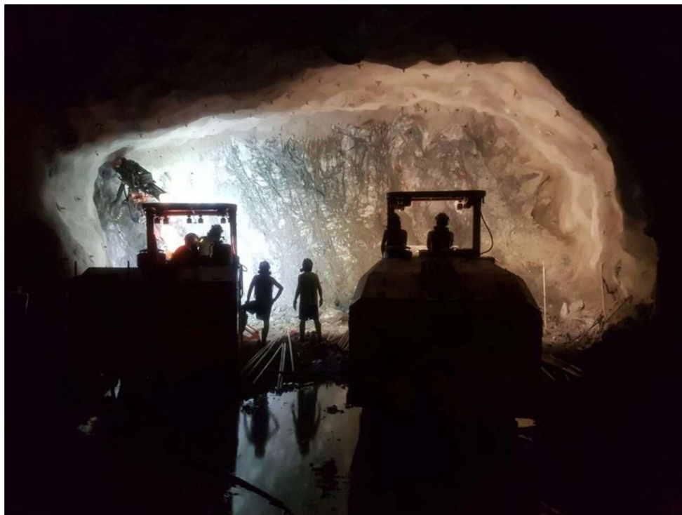
Fotografía 2.2: Sistema de explotación mecanizado TJ2927–Nv. 1915 – Balcón.
