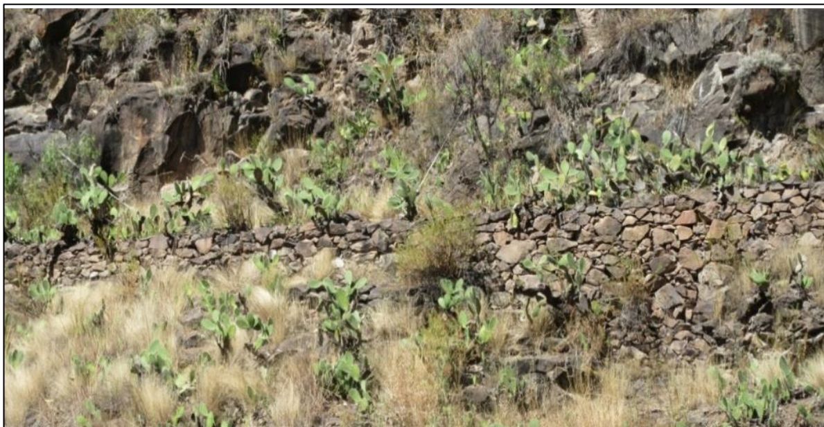
Fig 15: Imagen del muro de contención del camino Wari, ubicado en las faldas del cerro Chaqowillka.
