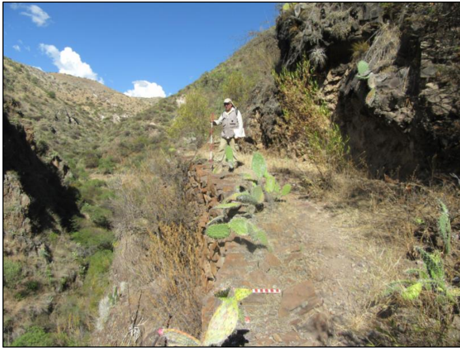
Fig 13: Imagen fotográfica del camino con presencia muro de contención, lado izquierdo del río Chiwa.
