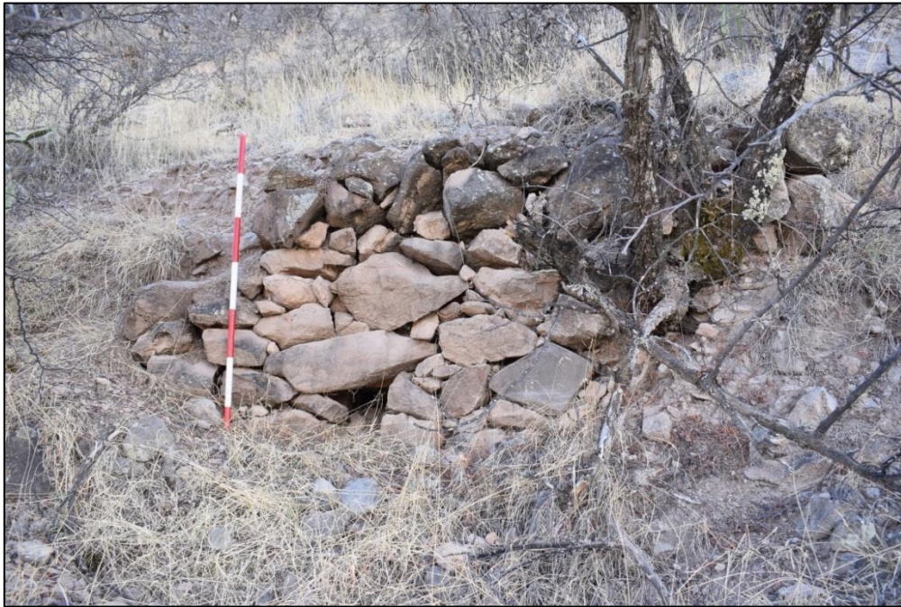
Fig 40: Fotografía de la alcantarilla debajo del camino.
