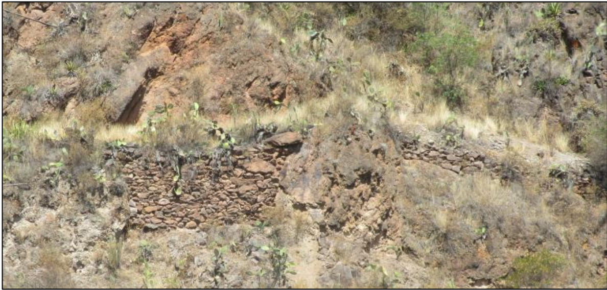
Fig 21: Imagen fotográfica del muro de contención del camino Wari.
