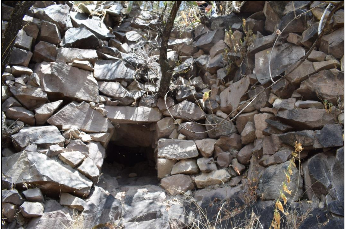
Fig 39: Fotografía de la alcantarilla y encima el camino.
