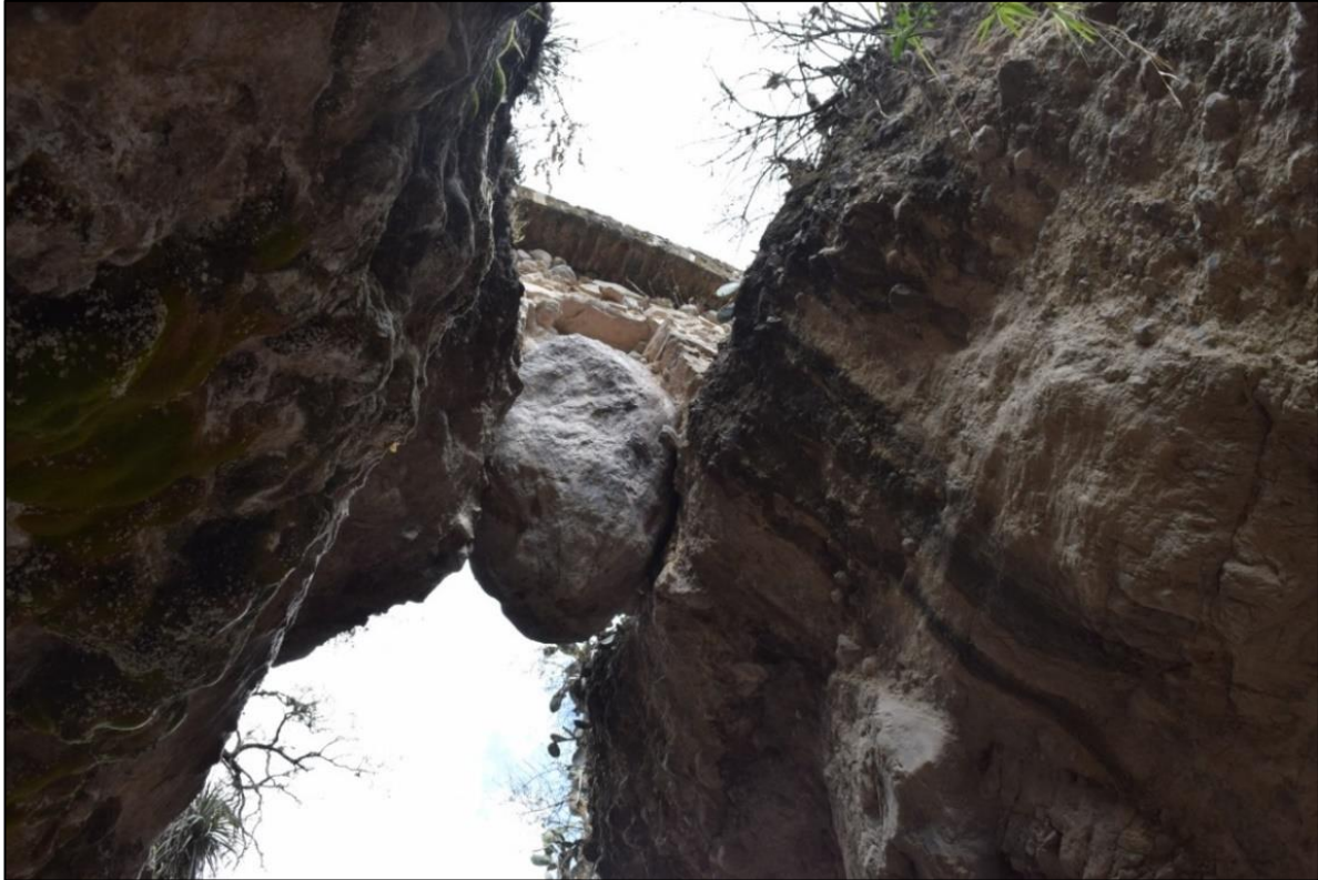
Fig 42: Fotografía del puente de Rumichaca – Vista inferior.
