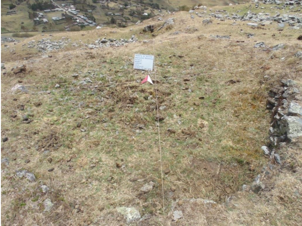
Figura 13: Estructura en forma circular, solamente se notan la cabecera del muro, el techo esta desplomado posiblemente fue de ichu y palos.
