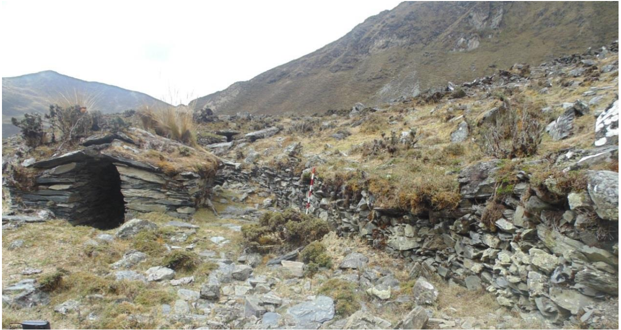
Figura 17: Muro de contención, construyeron para la protección de la chullpa.
