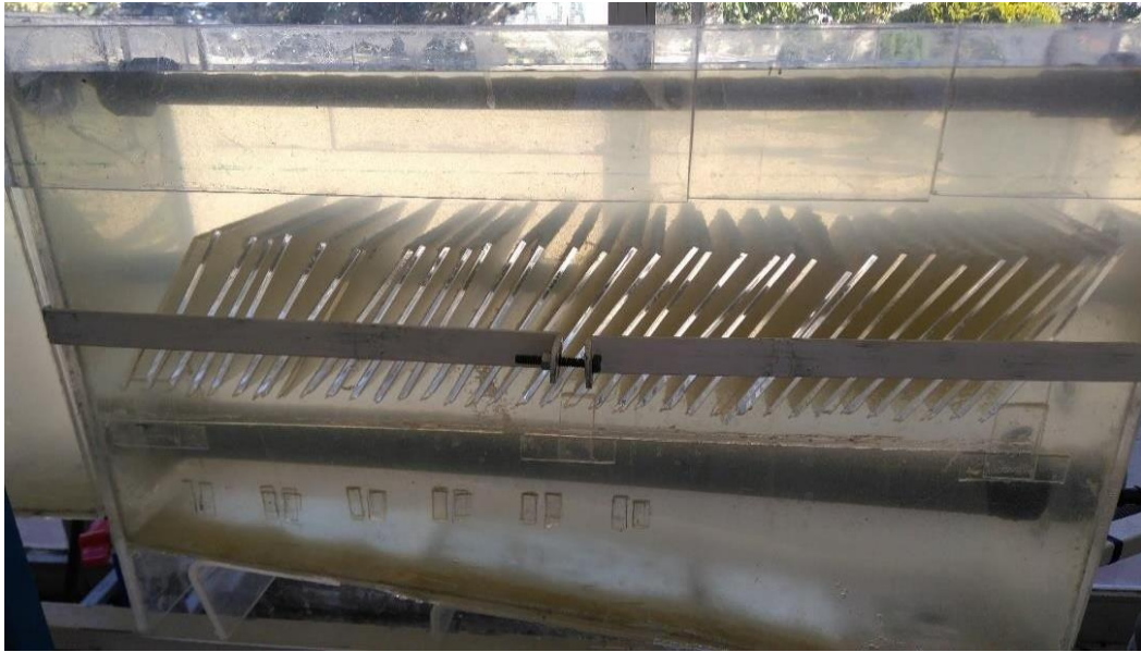
Vista de la unidad de Sedimentación
