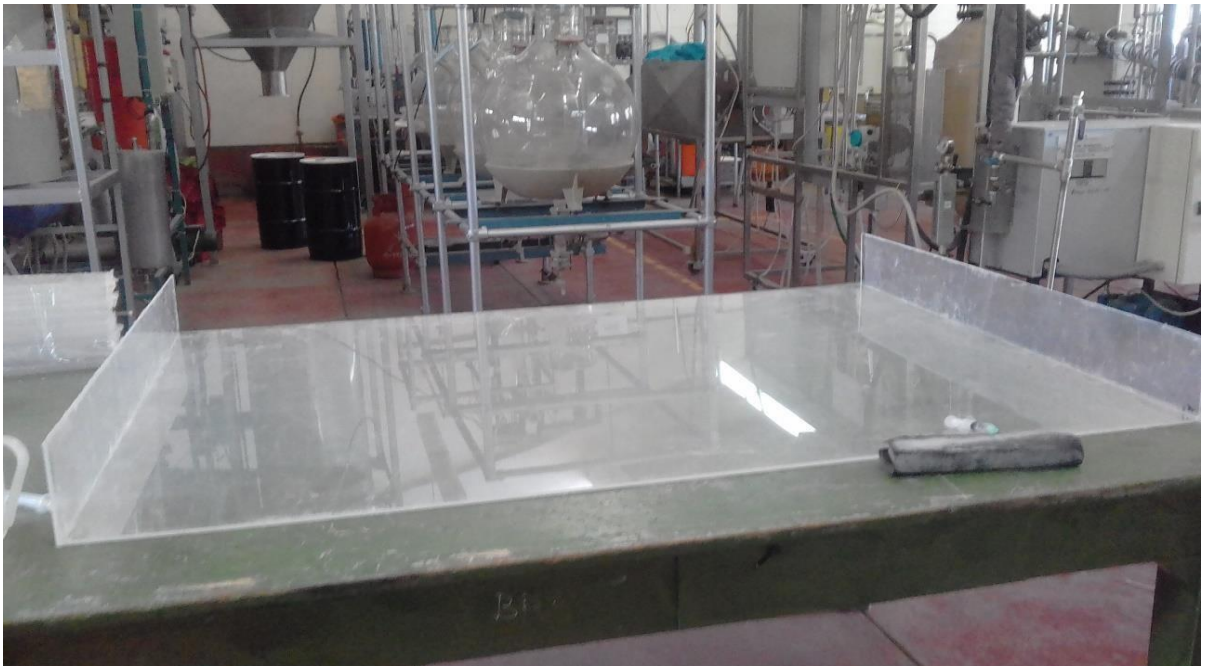
Vista de la construcción del tanque floculador
