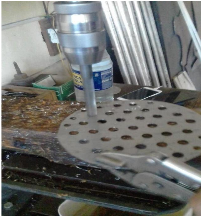
Vista de construcción del soporte de lecho
