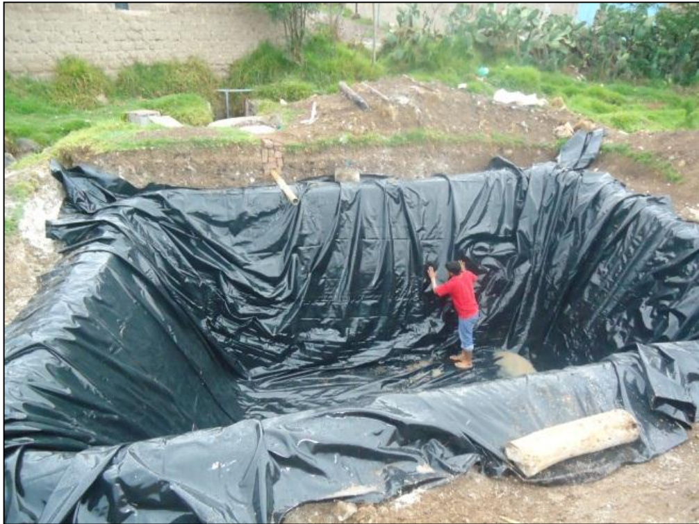
Fotografía 05. Tendido de la geomembrana
