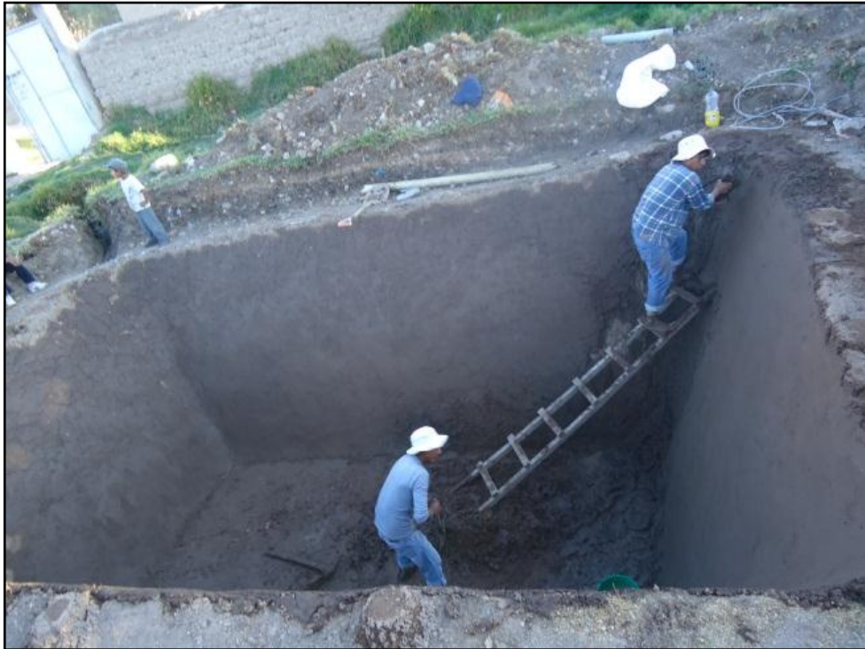
Fotografía 03. Recubrimiento del reservorio con barro
