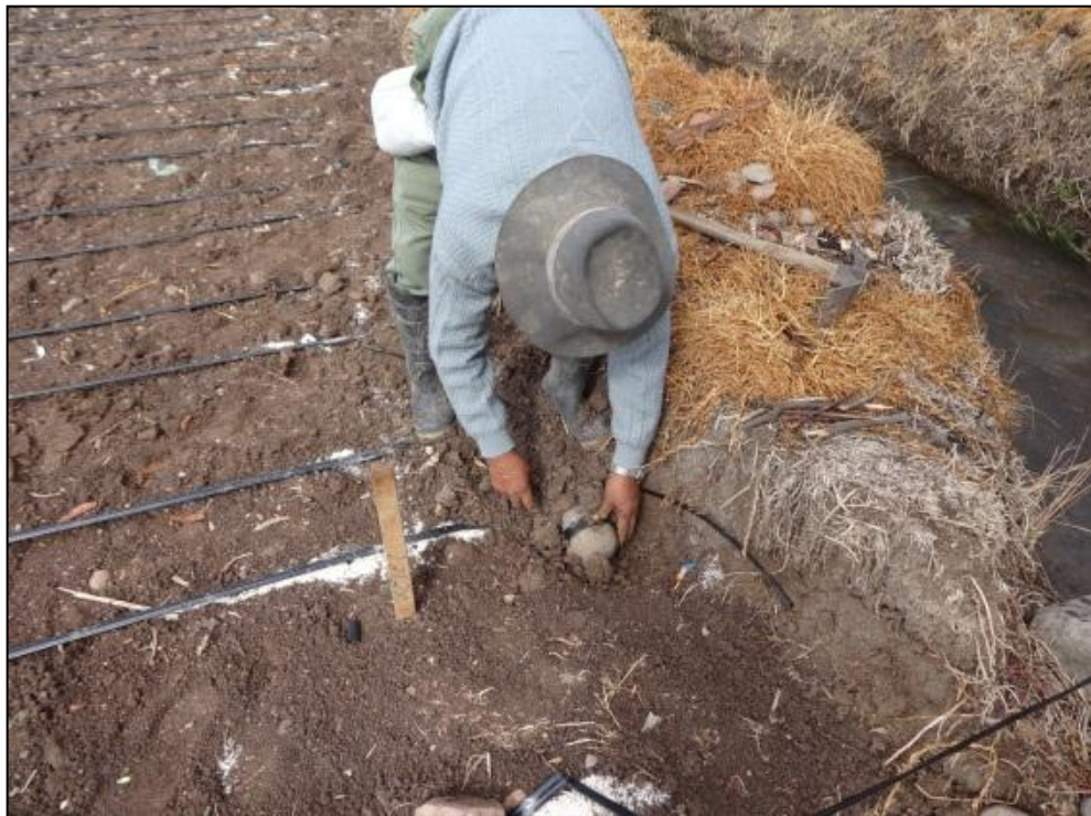
Fotografía 26. Anclaje de los laterales terminales
