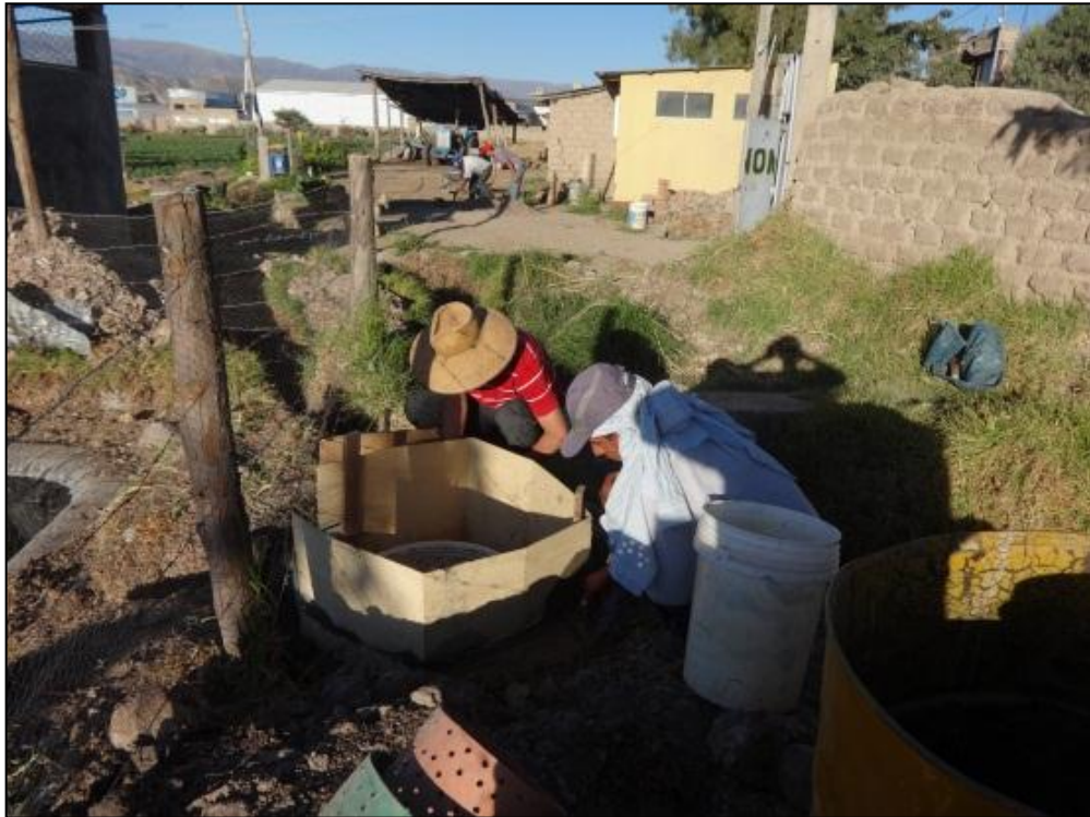
Fotografía 13. Construcción del prefiltro sedimentador
