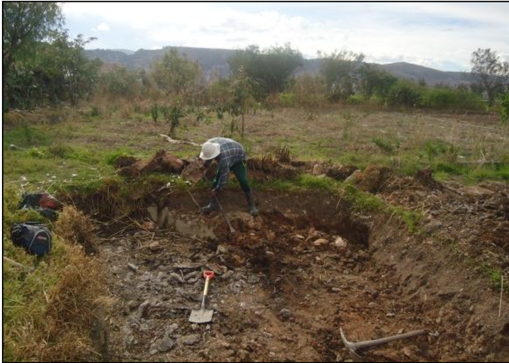
Fotografía 01. Excavación para el reservorio
