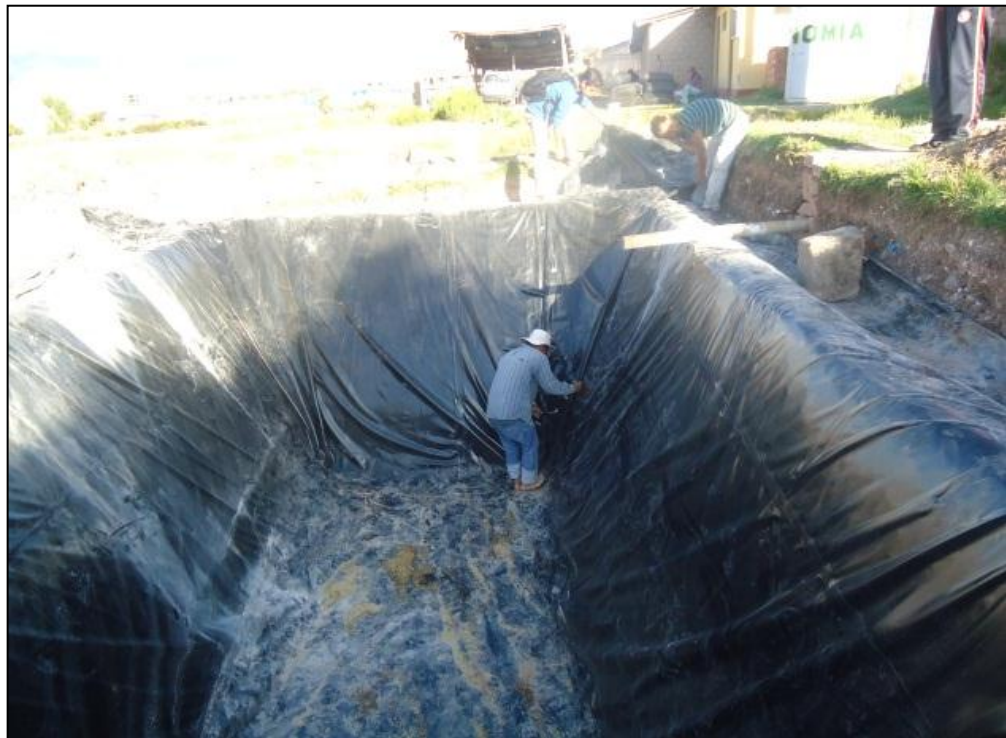
Fotografía 06. Anclaje de la geomembrana
