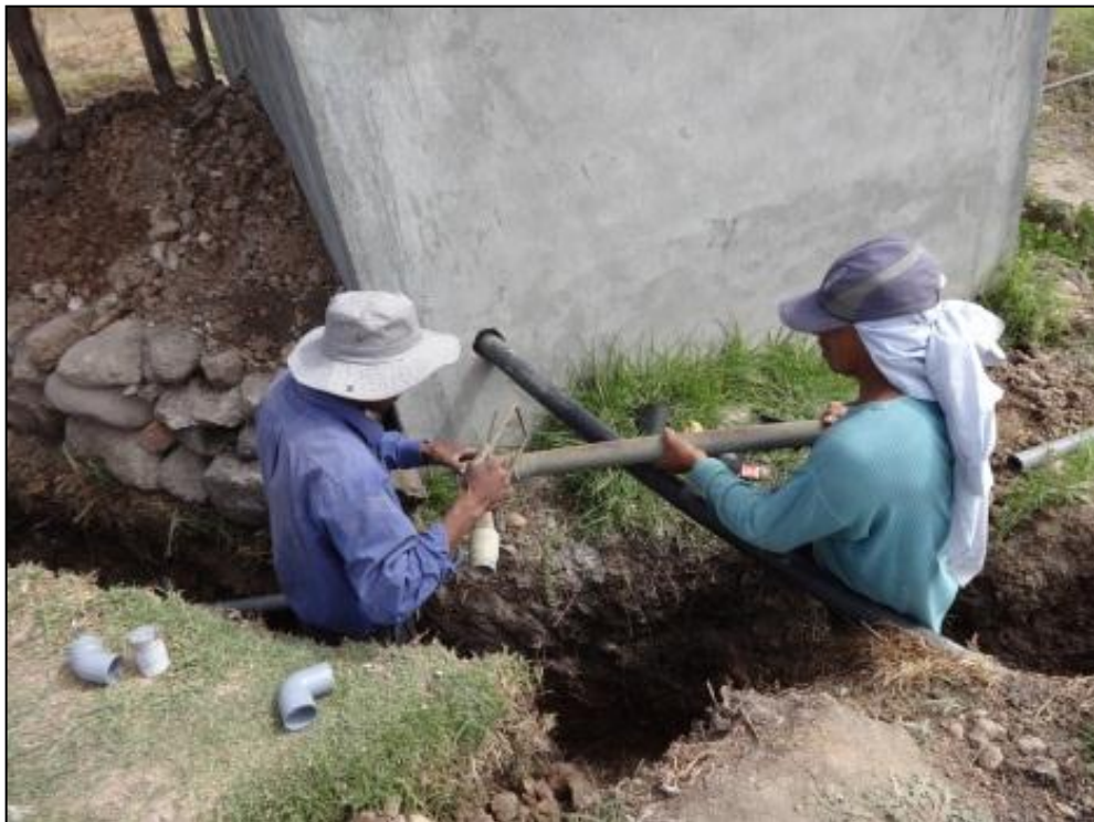
Fotografía 14. Construcción de la red de sedimentación
