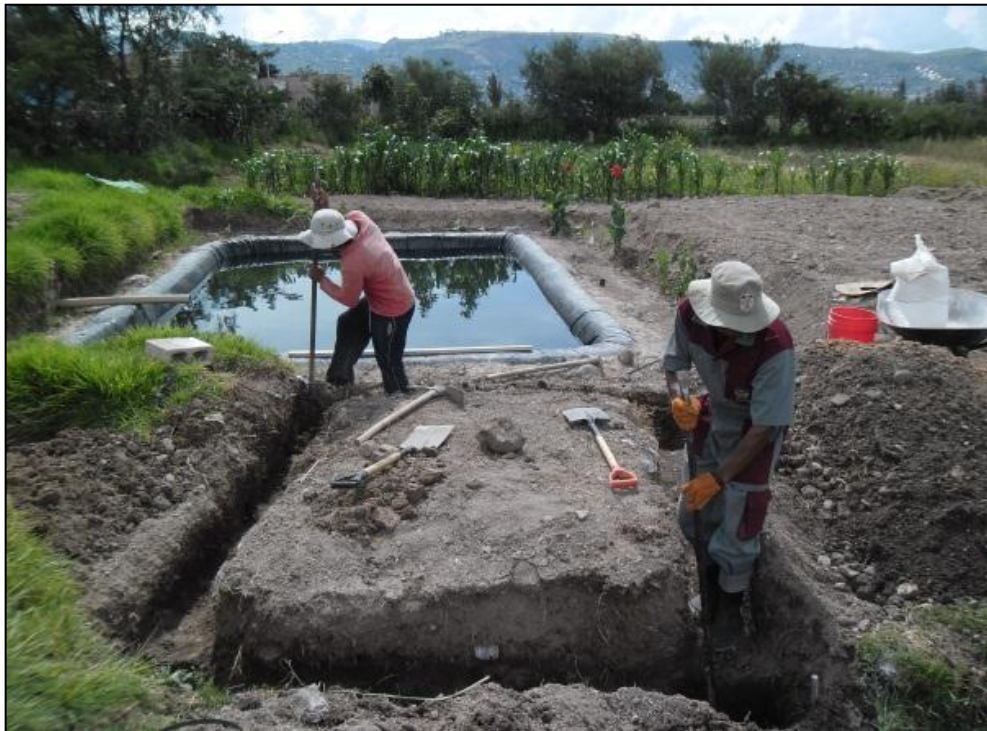
Fotografía 10. Excavación para la construcción del cabezal de riego
