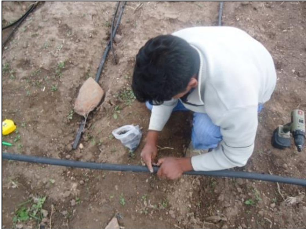
Fotografía 19. Instalación del arco del portalateral de riego
