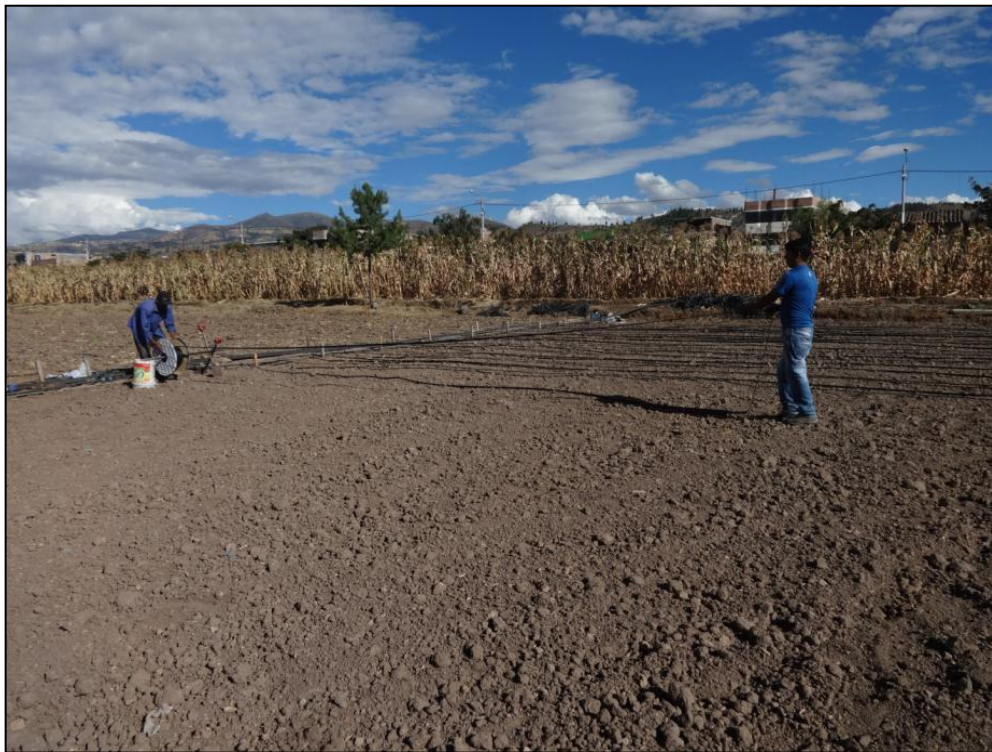
Fotografía 22. Tendido de cinta de goteo
