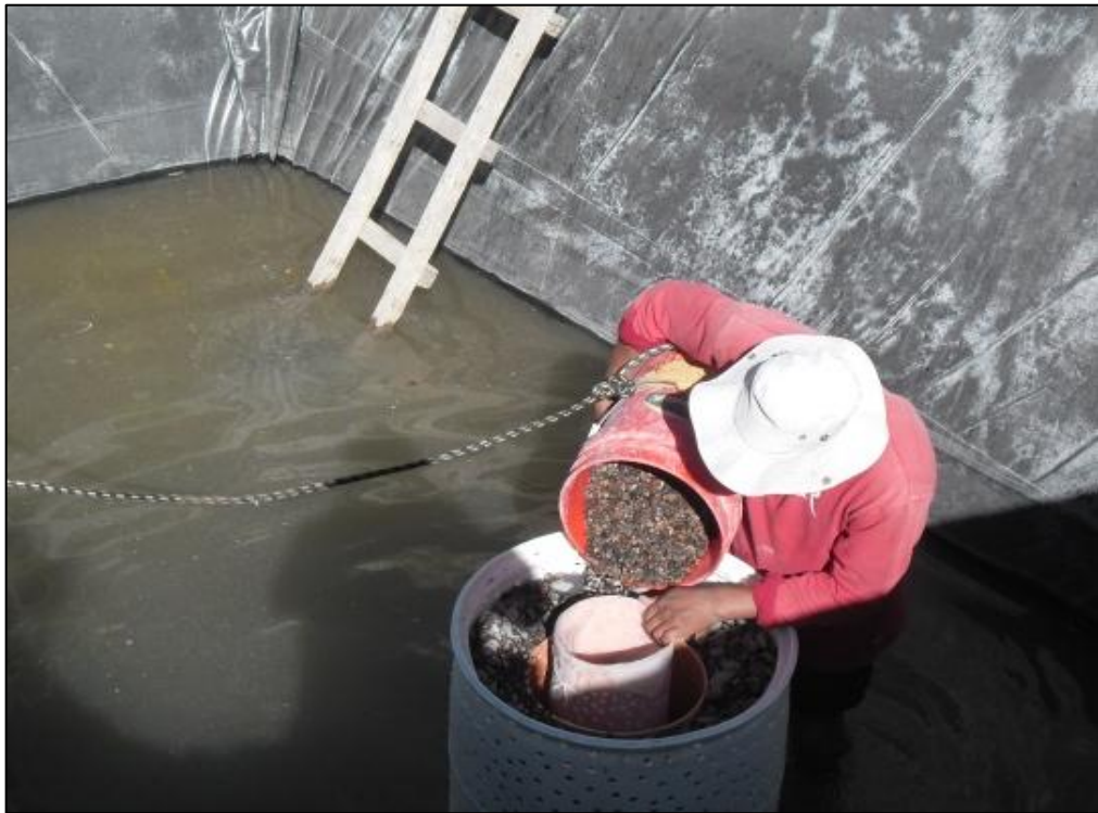
Fotografía 08. Instalación del filtro casero en el reservorio
