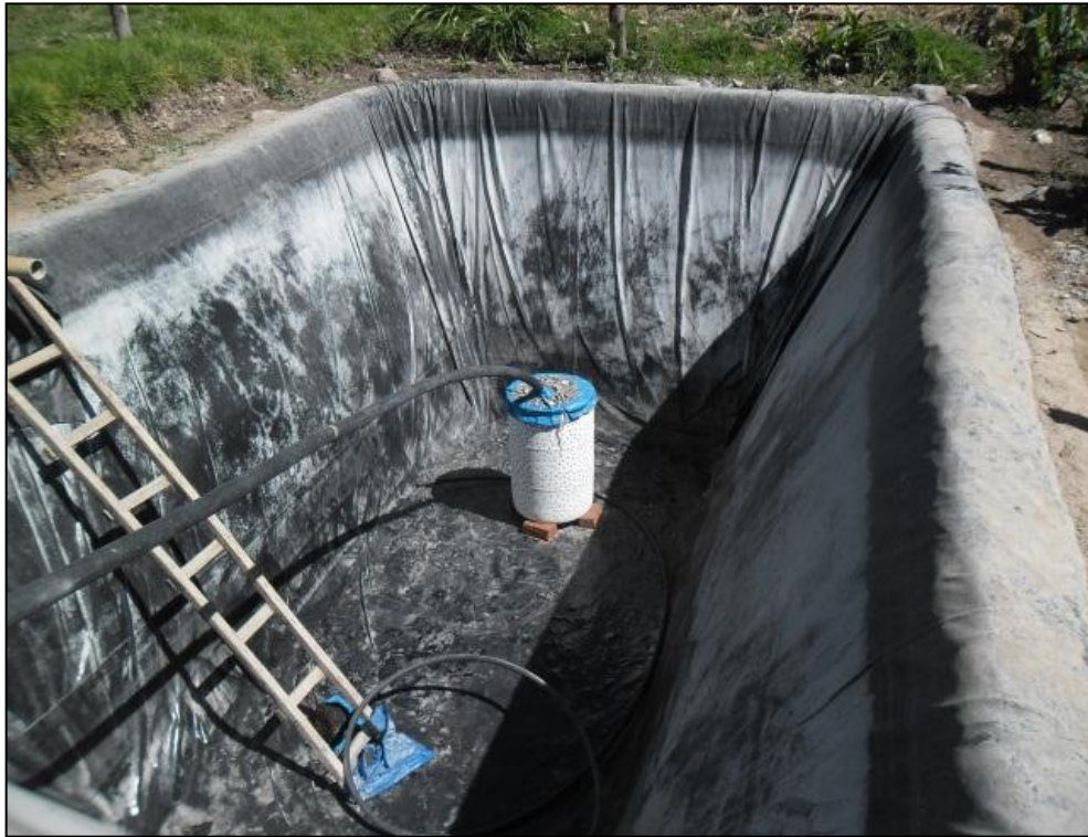
Fotografía 09. Conexión de la manguera de succión al filtro casero
