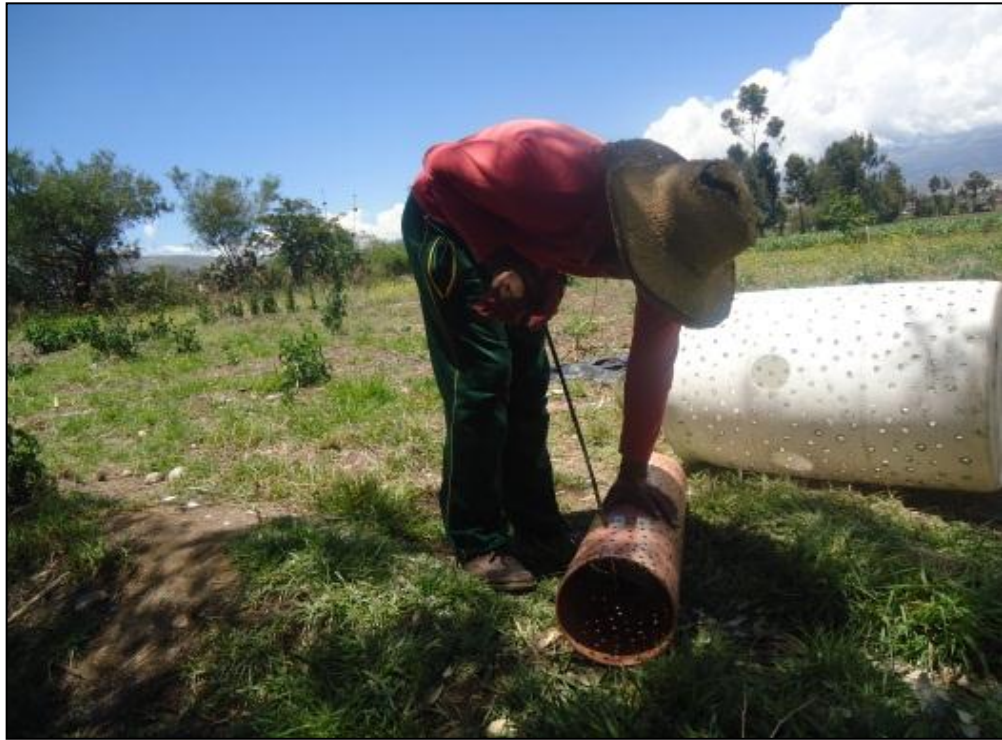
Fotografía 07. Perforación de las canastillas de filtro
