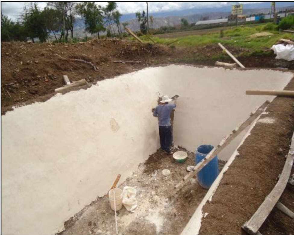
Fotografía 04. Recubrimiento del reservorio con yeso
