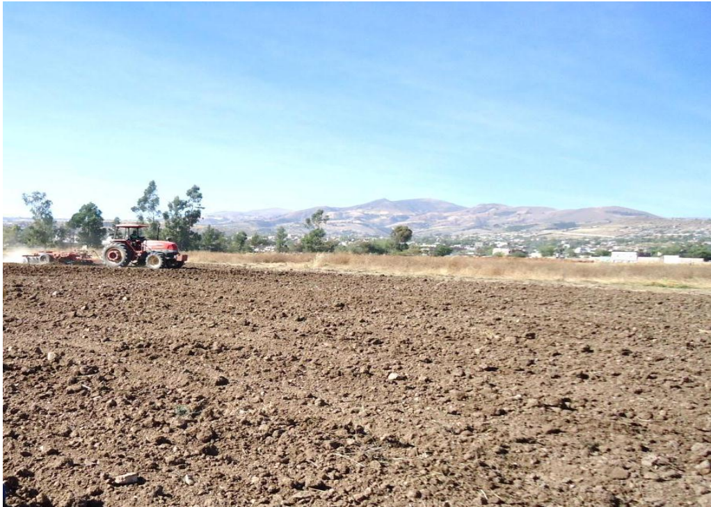
Foto 1. Preparación de terreno
