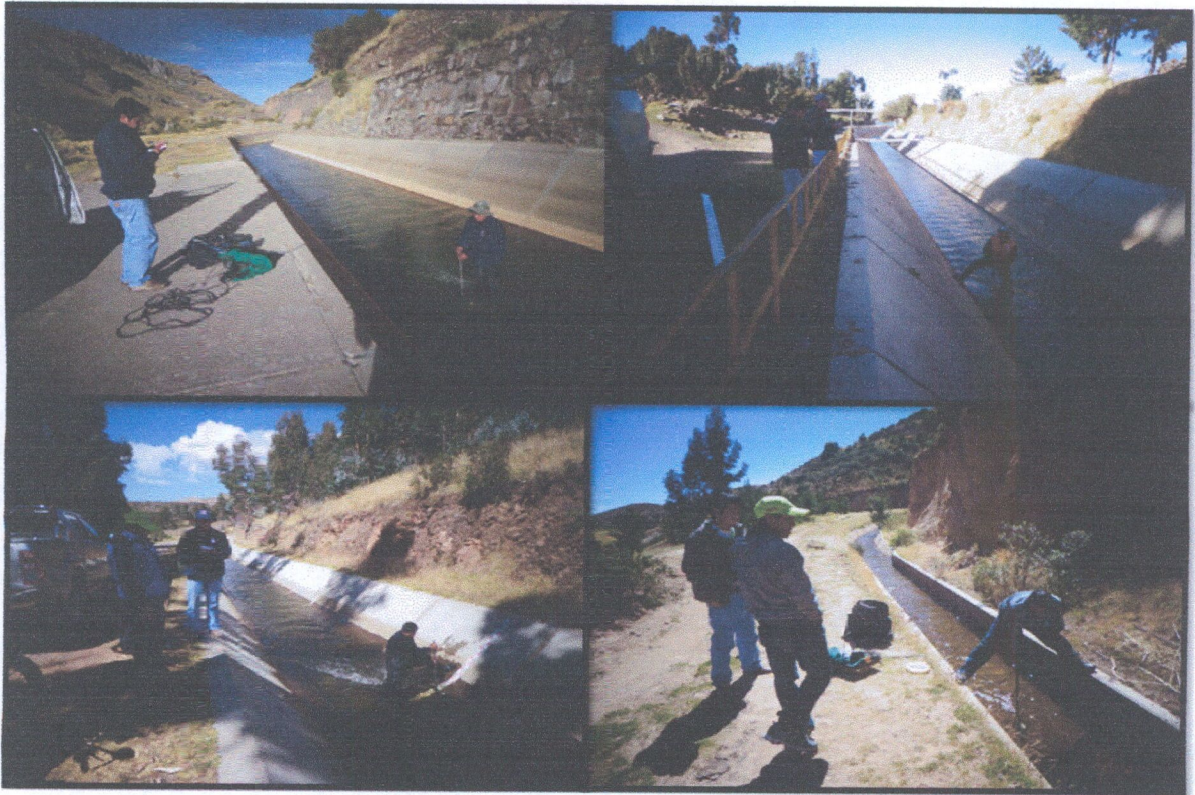
FIGURA .06 En la figura se observa mantenimiento del canal por deterioro en la juntas de dilatación y algunas fisuras.
