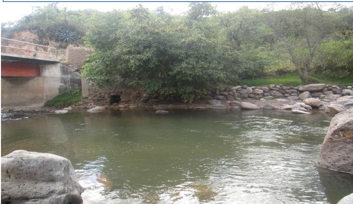
Figura N° 09 del anexo (panel fotográfico)
