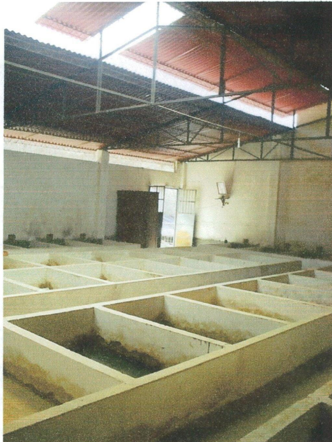
Foto N° 02: Infraestructura del galpón (interior)
