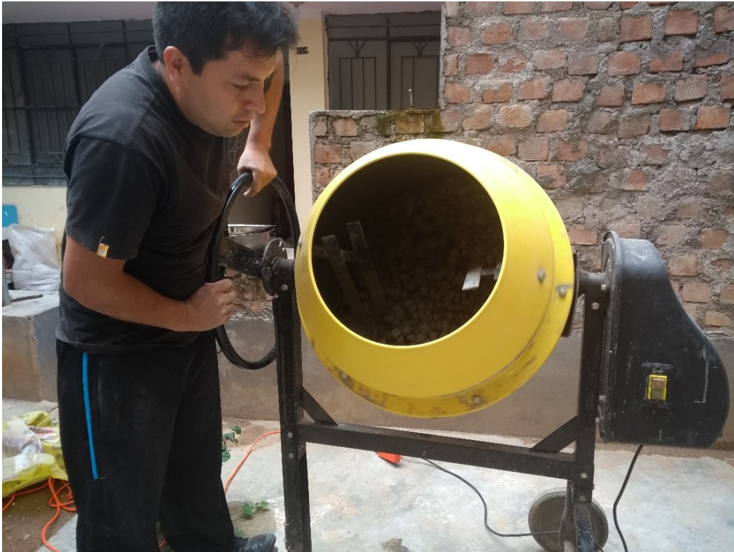
Figura C.7 Elaboración de la mezcla del concreto patrón.
