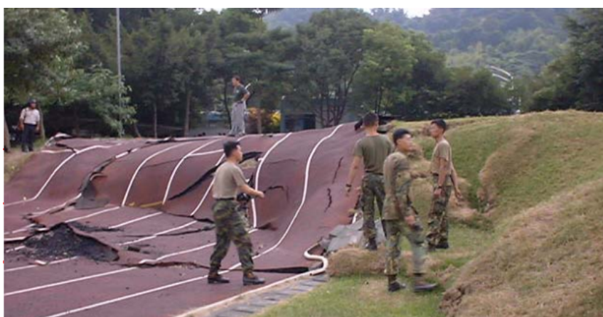
Figura 2.2: Ruptura en superficie que atraviesa la pista atlética de la escuela de Kuangfu, terremoto de Chi-Chi, 1999, Taiwan
