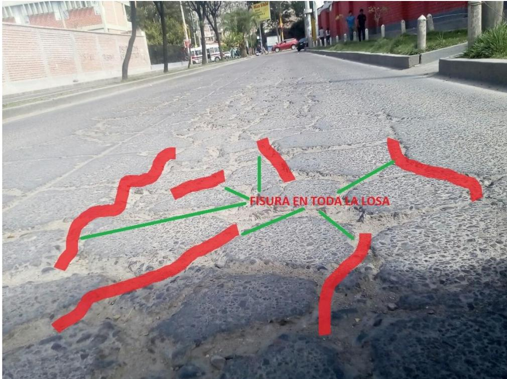
Figura 23: Fisura en toda la losa.
