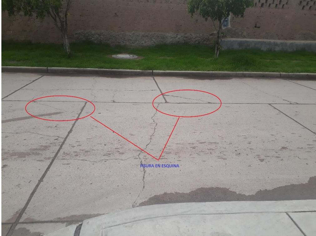
Figura 22: Fisura en esquina de losa.
