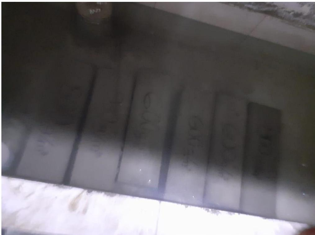
Figura 69: Curado de vigas de concreto
