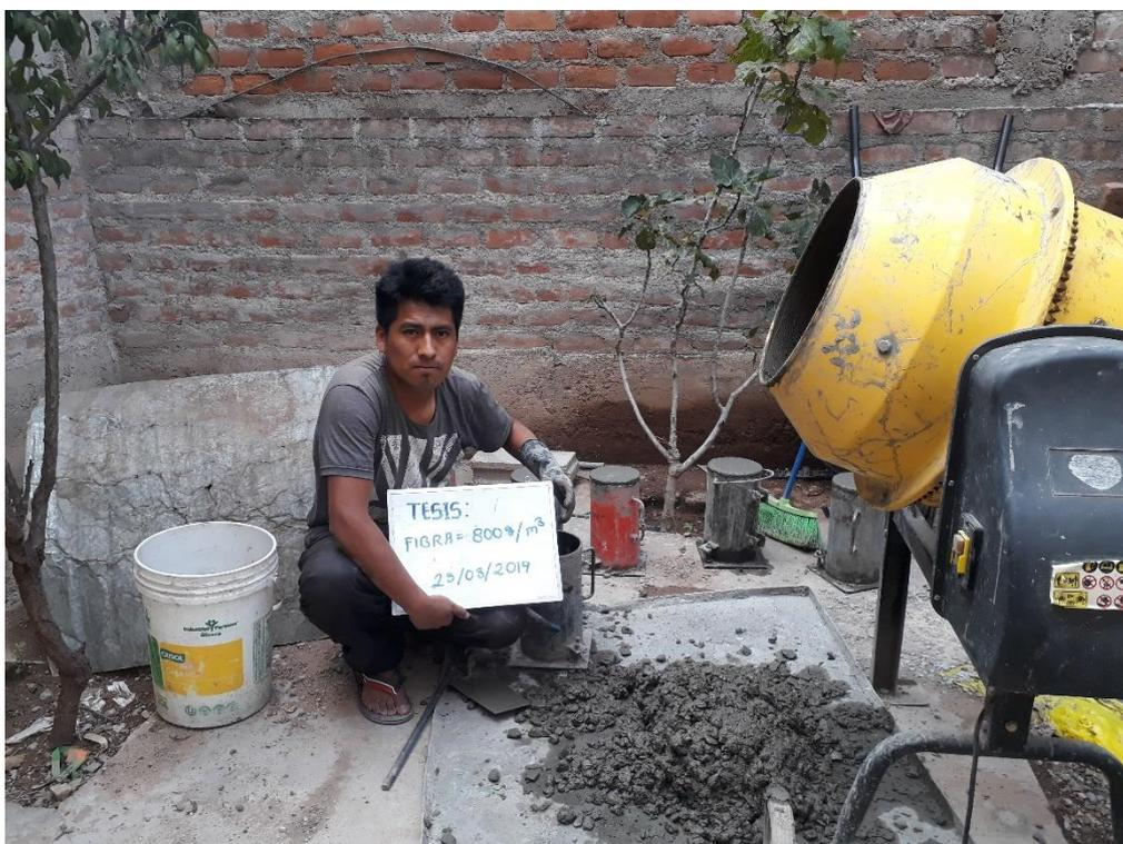
Figura 49: Preparado del concreto adicionando fibra 800g
