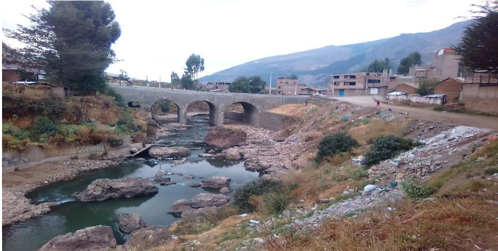
Figura 2.19 Contaminación del Rio Ichu
