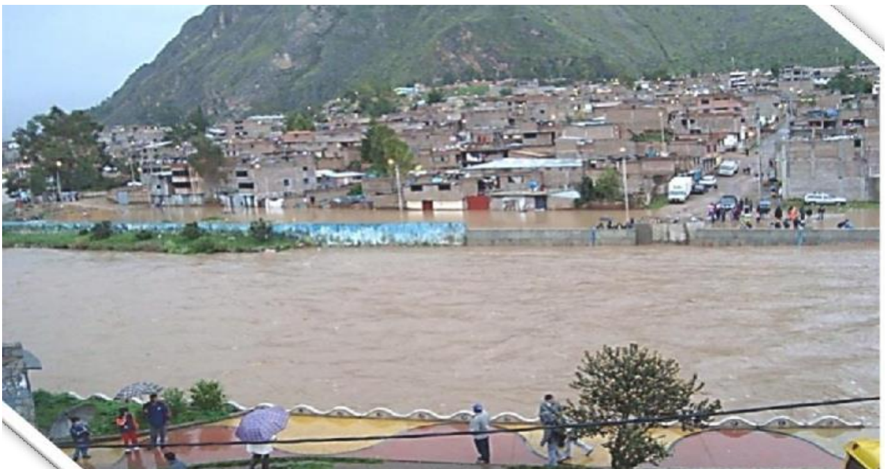
Figura B.8 Desbordamiento de muros de contención de concreto armado.
