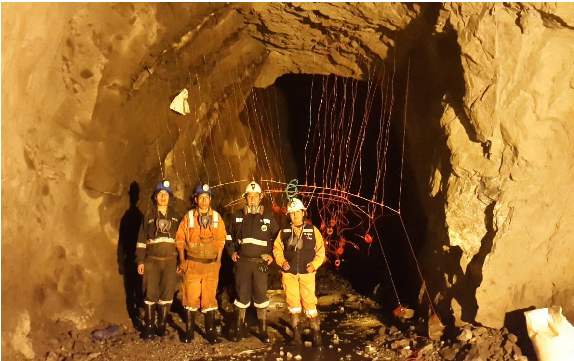
Taladros cargados en positivo con supervisión
