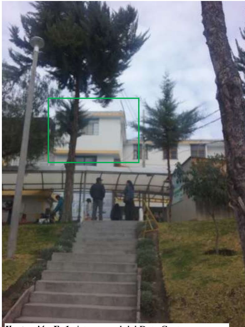
Ilustración F. 1 vista general del Data Center
