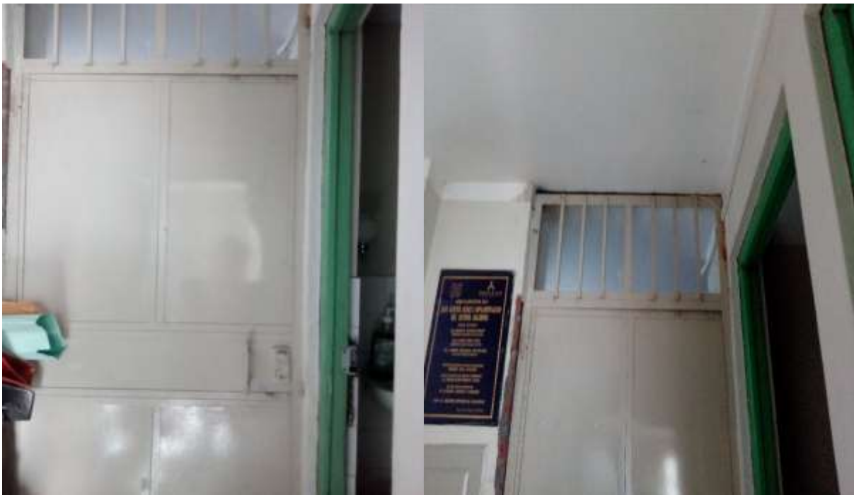
Ilustración F. 3 puerta del Data Center
