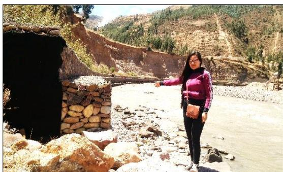
**Fotografía N° 03:** En la visita al campo de fecha 17/09/2017, se observó las condiciones de la defensa ribereña, evidenciando la oxidación y deterioro de los gaviones, además del desbordamiento de las piedras por la crecida del corriente del río Vilcanota, defensa construida en el centro poblado de Ccolcca, distrito de
