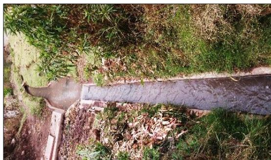
**Fotografía N° 06:** En la visita a la obra de fecha 15/09/2017, se evidenció tubos instalados que se encuentran a la intemperie, debido a la falta de la culminación de la obra en la comunidad de Pampaconga distrito de Limatambo, provincia de Anta – Cusco.
