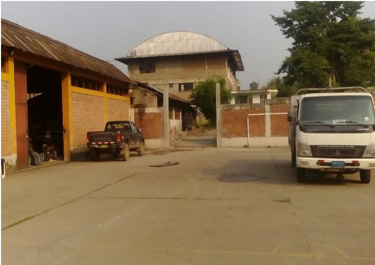
Instalaciones del Centro de Acopio N° 01 –Distrito de Sivia
