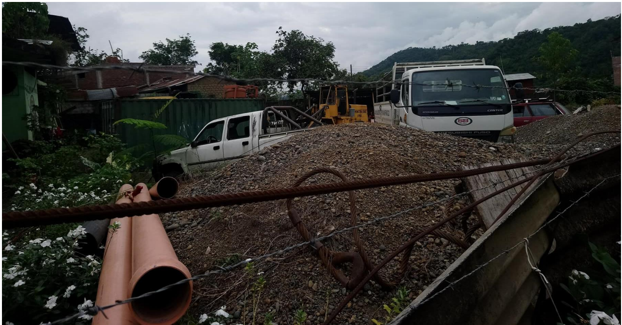
Secadero frontal Cooperativa Agraria Cafetalera “INKAFE VRAE” usado como garaje y desmonte
