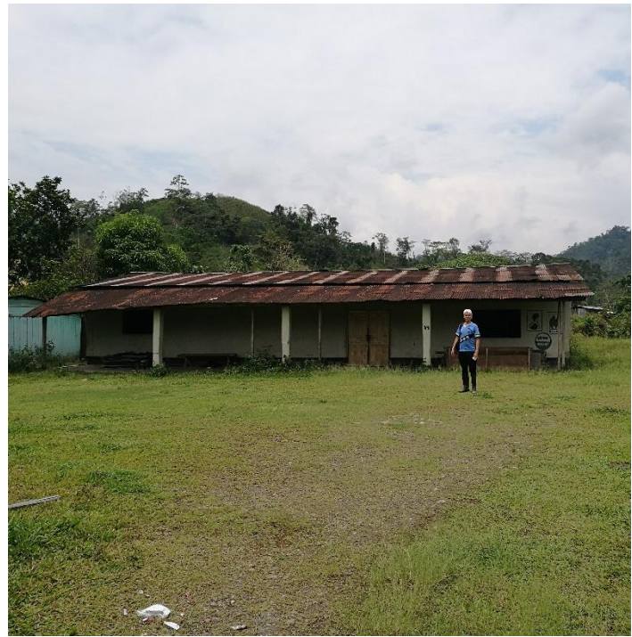
Instalaciones del Centro de Acopio N° 03 en el Distrito de Llochegua, 1dra Abajo Centro Salud Llochegua
