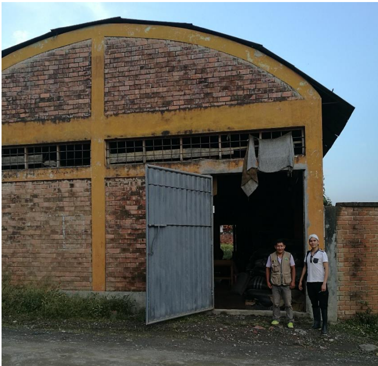
Instalaciones del Centro de Acopio N° 02 en el Distrito de Pichari, Ubicada hacia la salida carretera Pichari-Kimbiri
