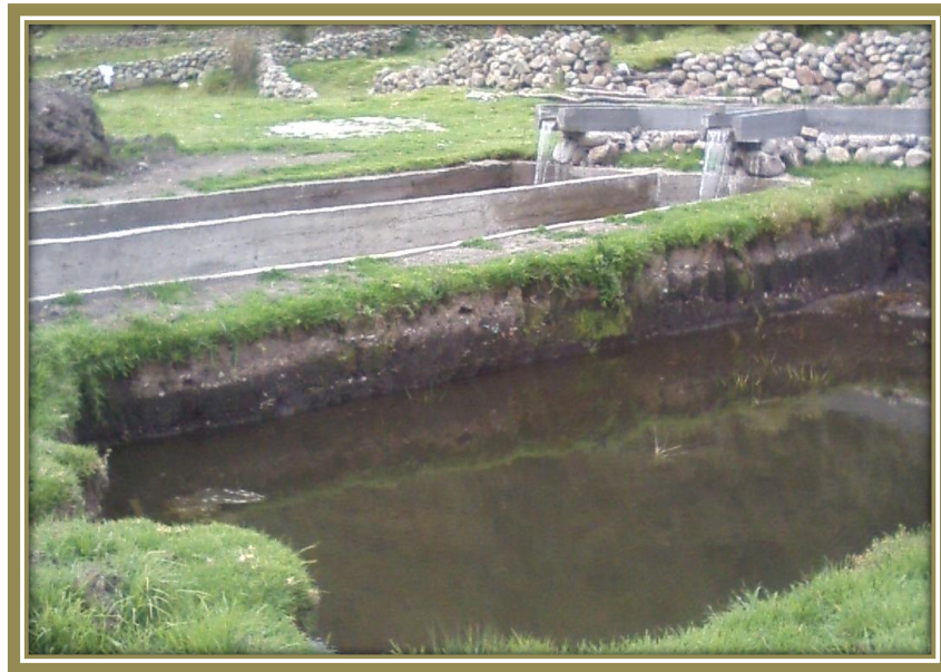
Foto 5. Estanques de crianza concreto y tierra
