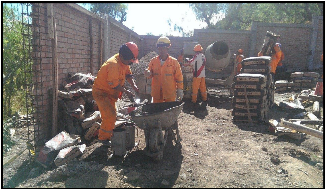
Obreros durante la ejecución de la obra
