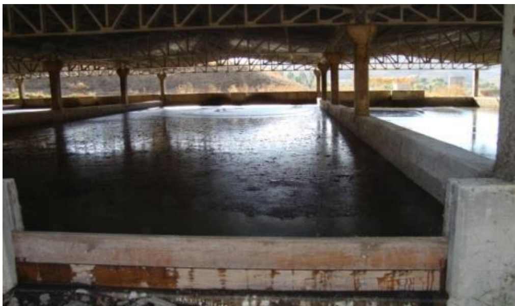
Anexo 22. Lechos de secado de la planta de tratamiento de aguas residuales Totorá, Ayacucho 2014.
