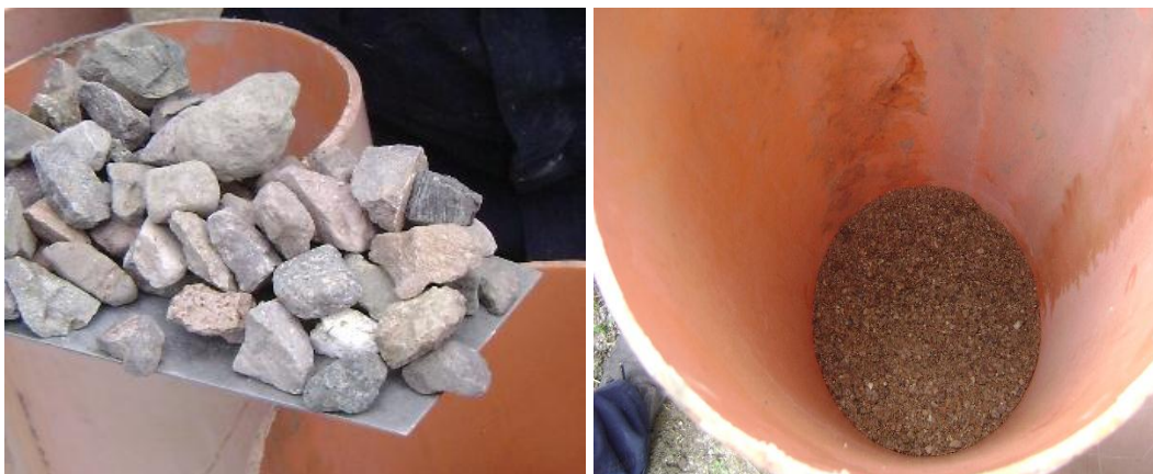
b) Colocación de la capa de grava y gravilla
