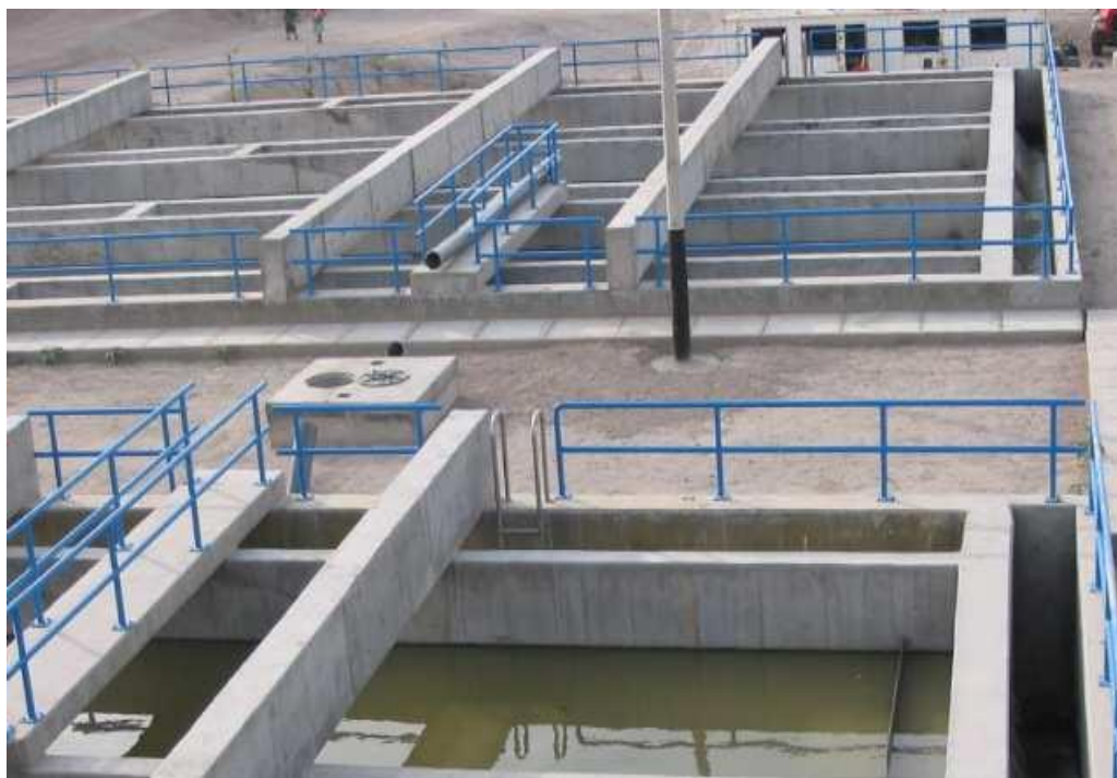
Anexo 21. Tanques Imhoff de la planta de tratamiento de aguas residuales Totora, Ayacucho 2014.
