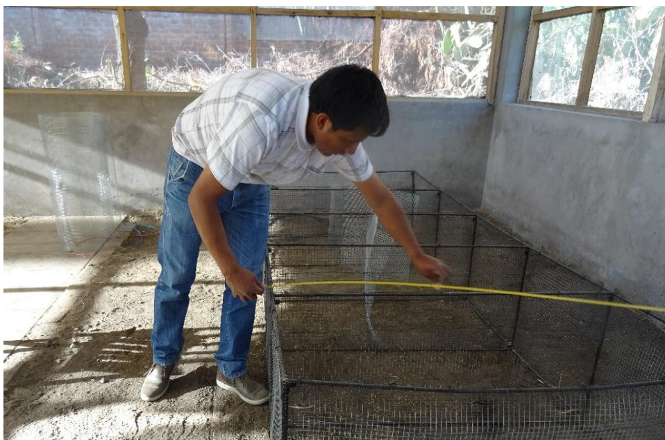
Figura 2.4. Pozas construidas con fierro corrugado y malla galvanizado
