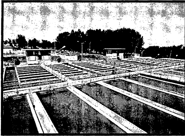
Figura N° 2.9: Planta de tratamiento de agua potable (SEDALIB, 2010)
