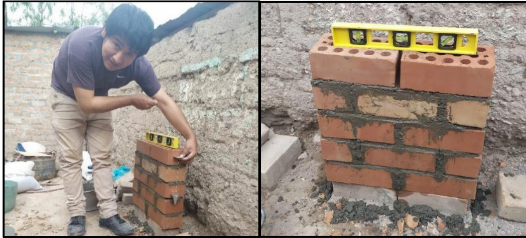
Figura 2.36. Construcción de muretes de ladrillos King Kong 15 huecos
