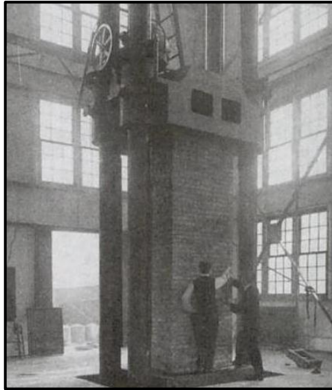
Figura 1.3. Muro a escala natural con carga axial de compresión (Estados Unidos 1916)
