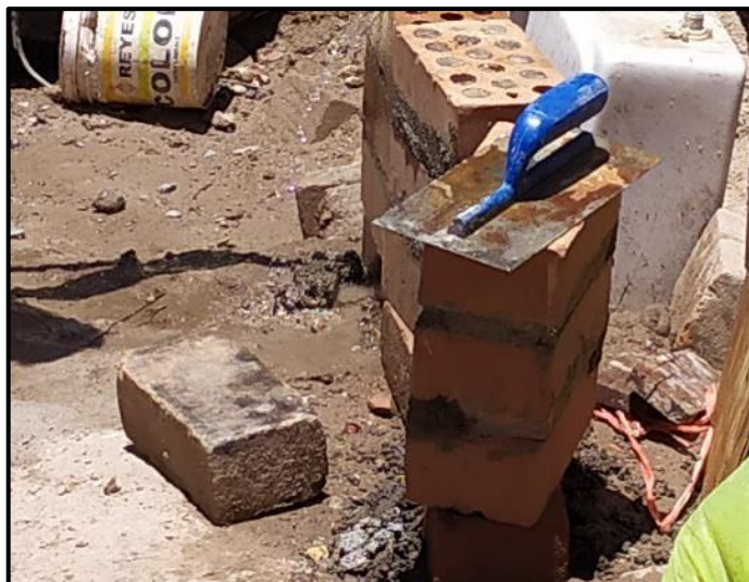
Figura 2.32. Construcción de pilas de ladrillos King Kong 15 huecos
