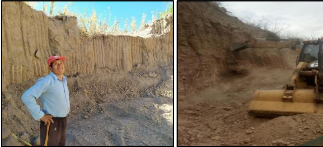
Figura 2.7. Izquierda; cantera de arcilla. Derecha; extracción de arcilla con maquinaria
