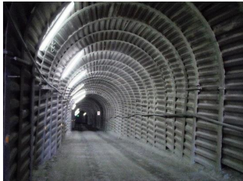
Figura 4.7. Sistema de cimbras para el sostenimiento de labores principales
