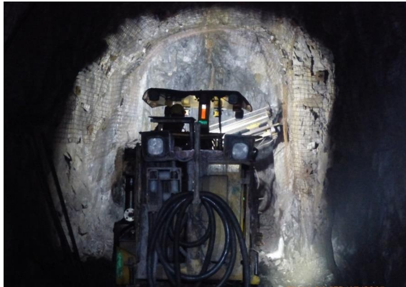
Figura 14: Sostenimiento Mecanizado con Equipo Small Bolter en SN 104 E.
