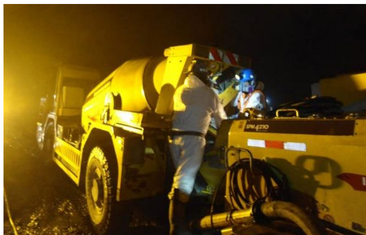
Figura 27: Equipo Mixer para el Transporte de Shotcrete.
