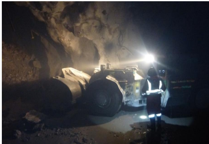
Figura 13: Limpieza con Scooptram R1300 de 4.2 Yd 3 en SN 104 E.
