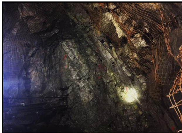
Figura 5: Caja Techo y Frente de Avance del Cuerpo “Rosita”, SN 583 N
