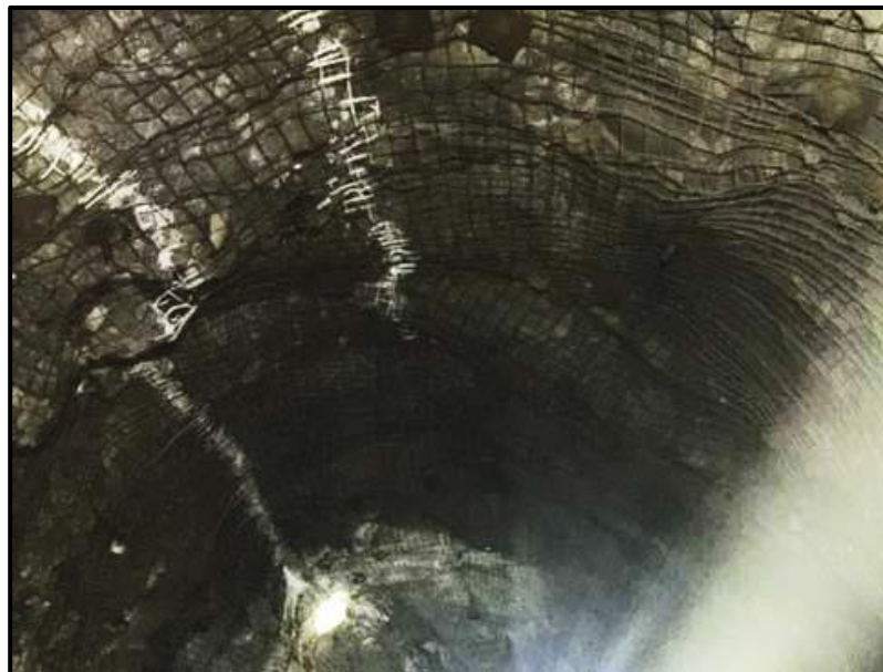
Figura 15: Cuerpo “Rosita” sostenida con Pernos y Malla, SN 583 N.
