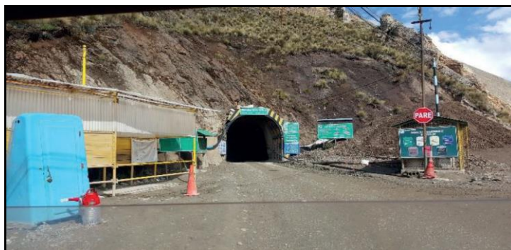
Figura 2: Ingreso a Labores Subterráneas de U. M. Morococha.
