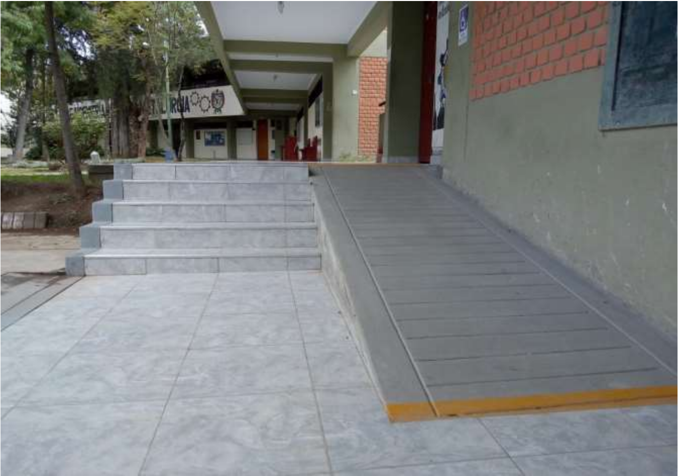
Foto. Gradas y rampas, pabellón H
