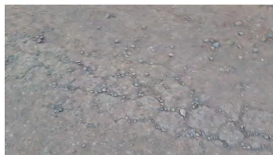
**(b)** Pavimento con ahuellamientos y grietas.**Figura 4** Problemas frecuentes que presentan los pavimentos con diseño convencional.
