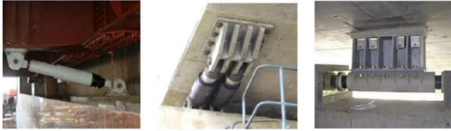
Figura 9 Ejemplos. Izquierda: Disipador RESTONSA. Medio: Disipador RESTON STU. Derecha: Disipador RESTON PSD.
