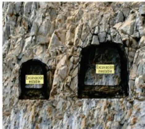
Figura 5. A mayor tamaño de la excavación se favorece la inestabilidad.
