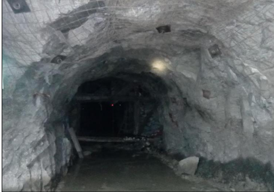
Fotografía 01: CR 397 del NV 3240 reforzado con pernos Split set y malla electrolosdada preparado para la construcción del refugio minero.
