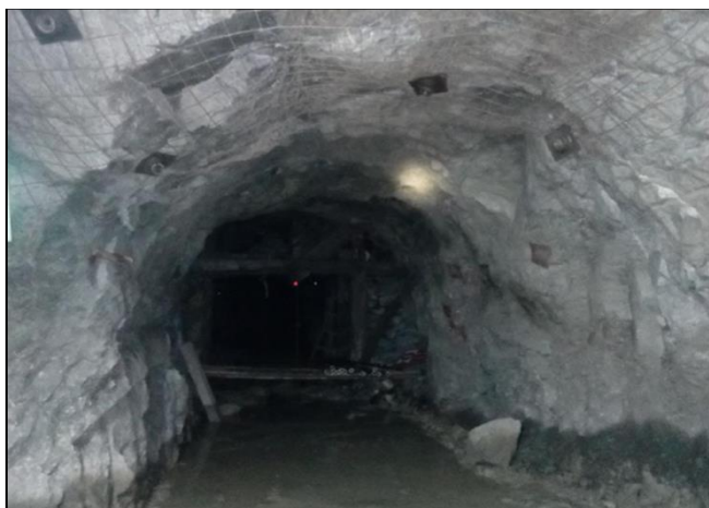
Fotografía 03: Sostenimiento del CR 397 NV 3240 con Pernos Split Set y Malla Electrosoldada.
