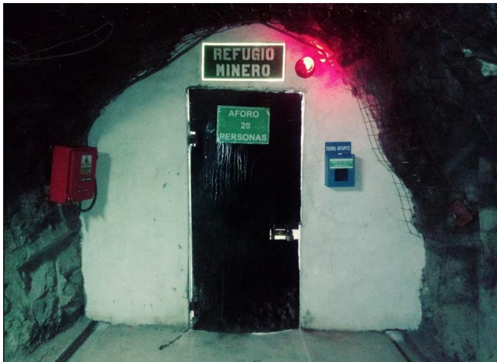
Fotografía 02: Estado del refugio minero fijo finalizado la construcción, vista de la entrada principal señalizado y herméticamente construido.
