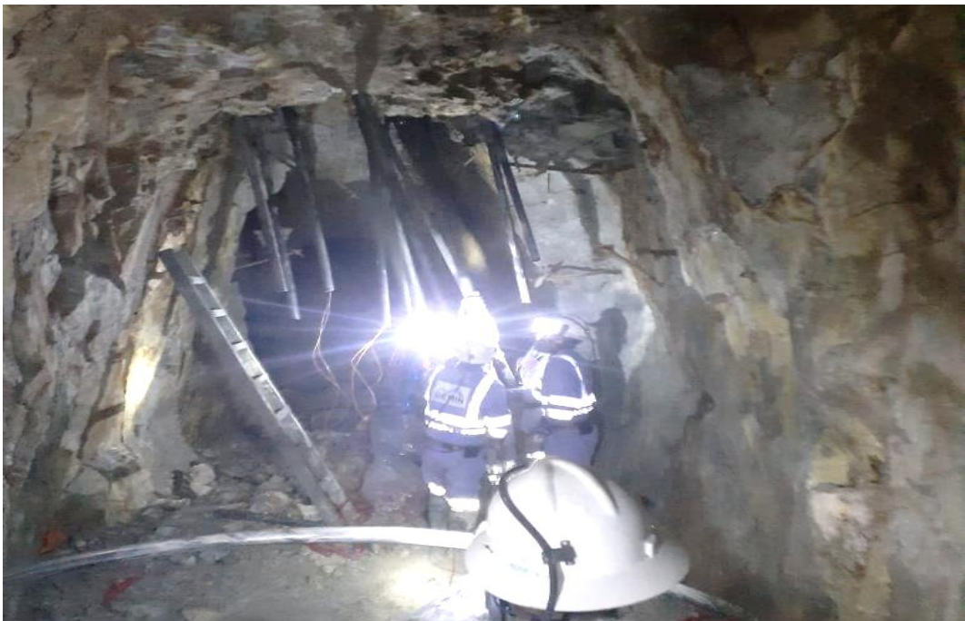
Foto 9. Instalación de conexión de accesorios de voladura
