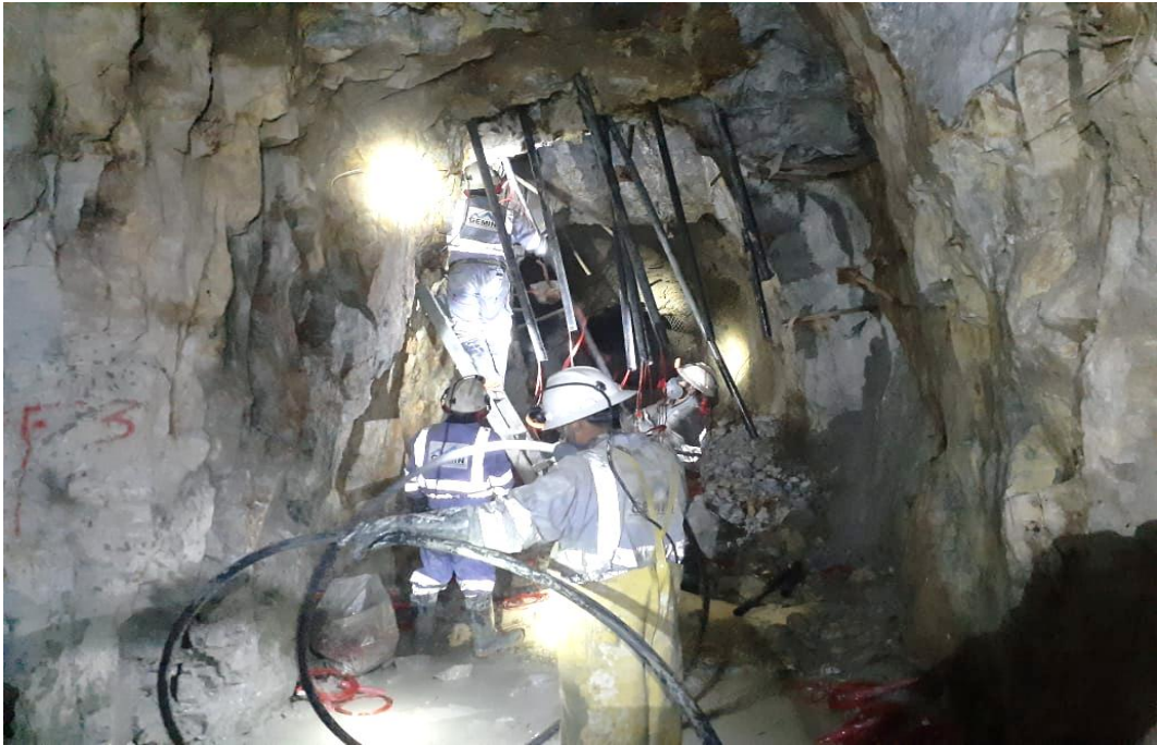
Fotos 6. Carguío de taladros 2
