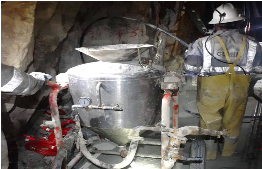
Foto 5. Carguío de taladro 1
