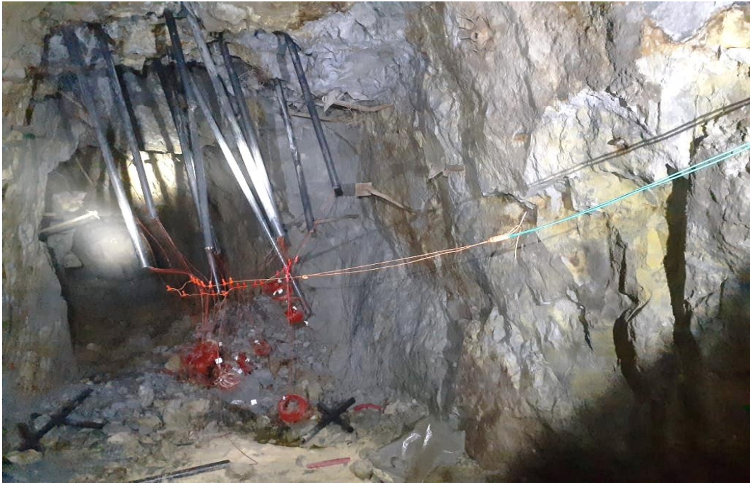
Foto 8. Conexión de accesorios de voladura
