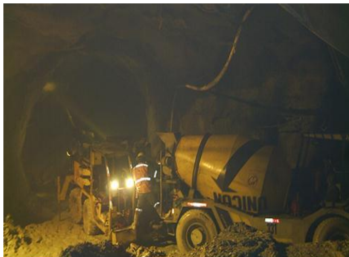
Figura 2.4. Proceso de Shotcrete Lanzado Vía Húmeda
