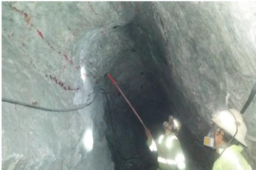
Figura 5: Marcado de la malla de perforación
