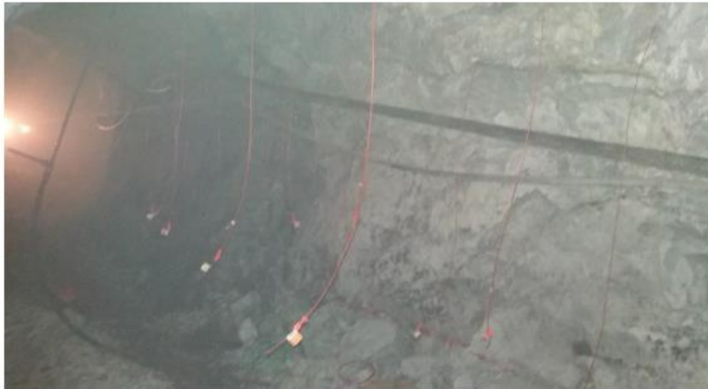
Figura 7: Carguío de Voladura
