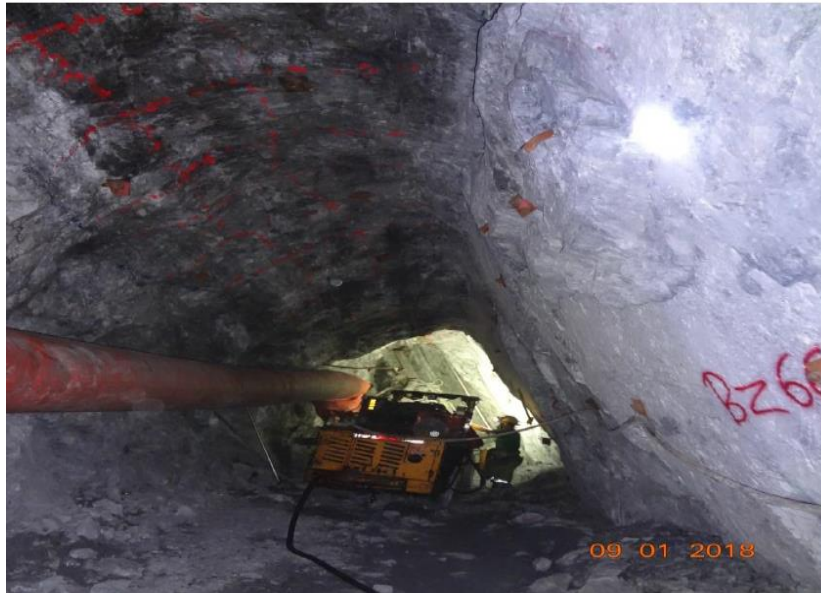
Figura 6: Perforación en Uper con Equipo mini jumbo Muki
