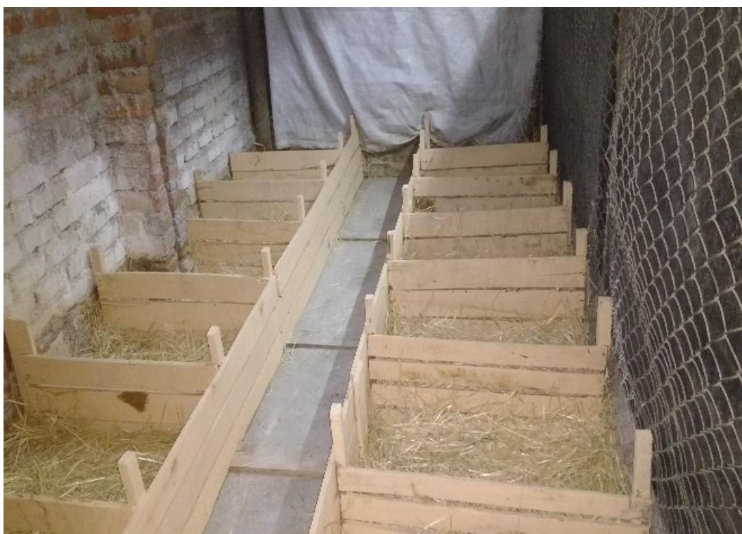
Foto 02. Acondicionamiento de las camas
