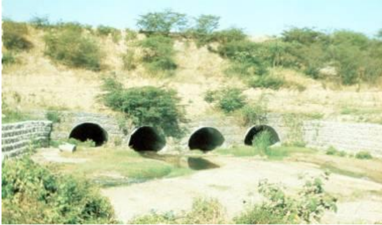
Figura 1.1 Batería de alcantarillas abovedadas
