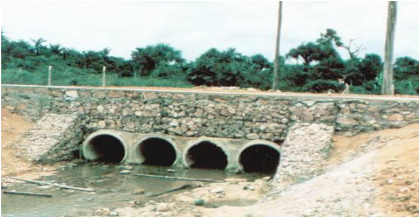
Figura 1.3 alcantarillas circulares de hormigón simple armado
