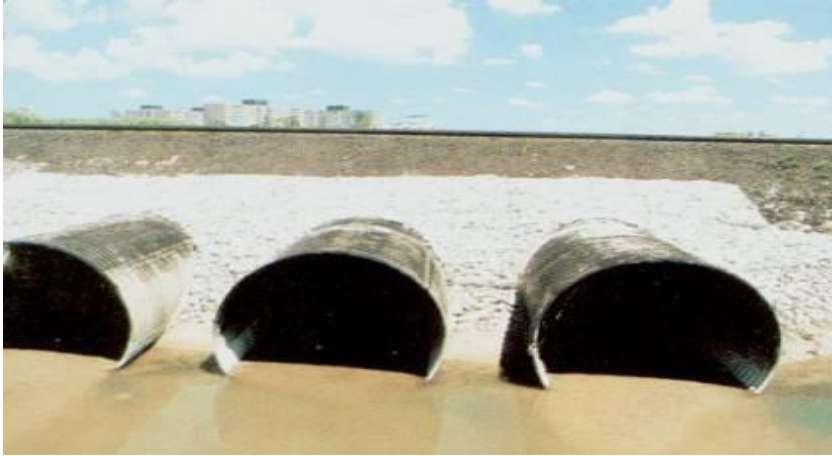
Figura 1.2 alcantarillas Metálicas circulares
