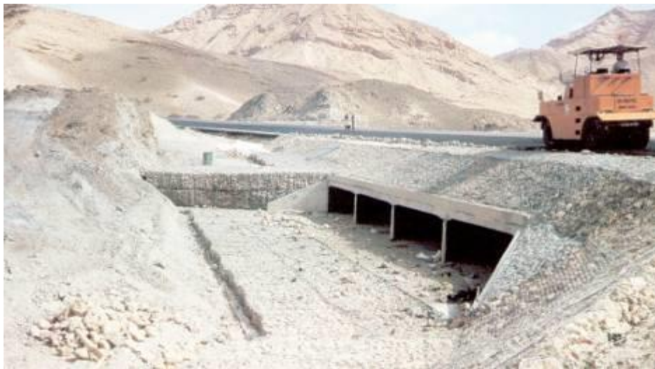
Figura 1.6 Alcantarillas Cajón de hormigón Armado
