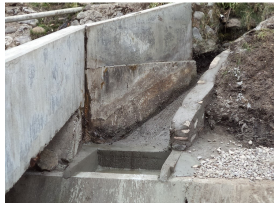
(b) Encauzamiento y mejoramiento de zanjas de coronación
