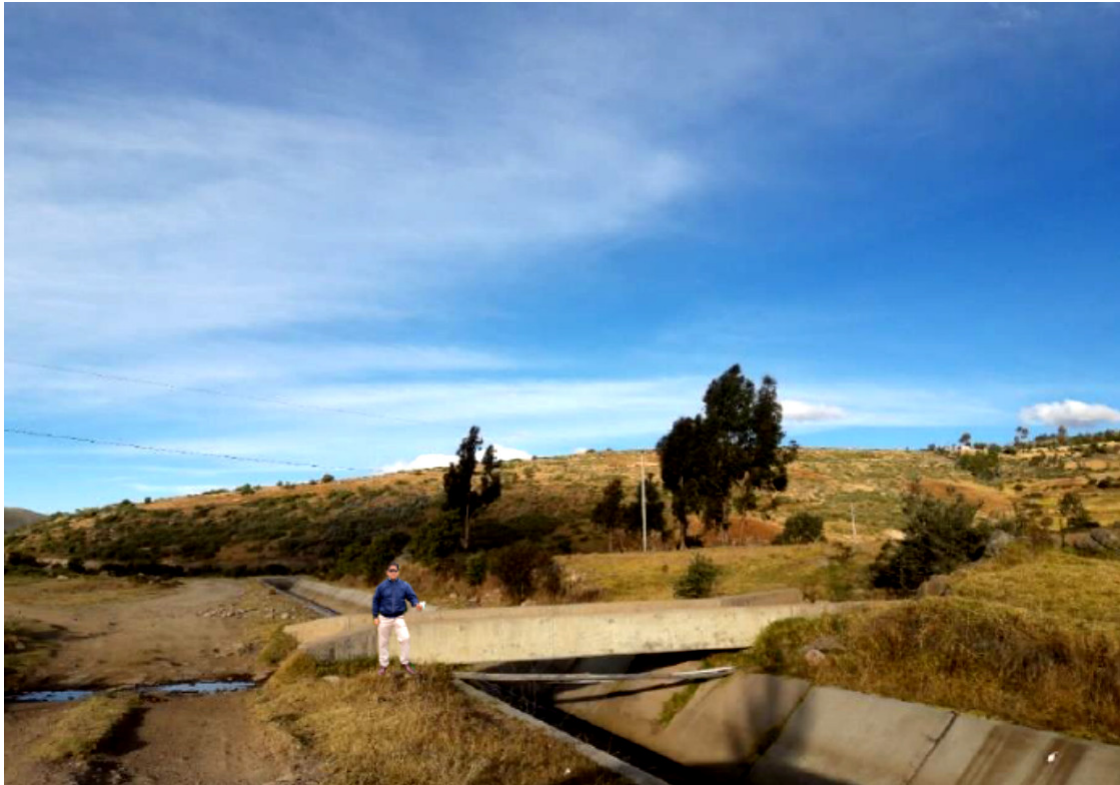
Figura A.5: Inspección del canal Cachi
