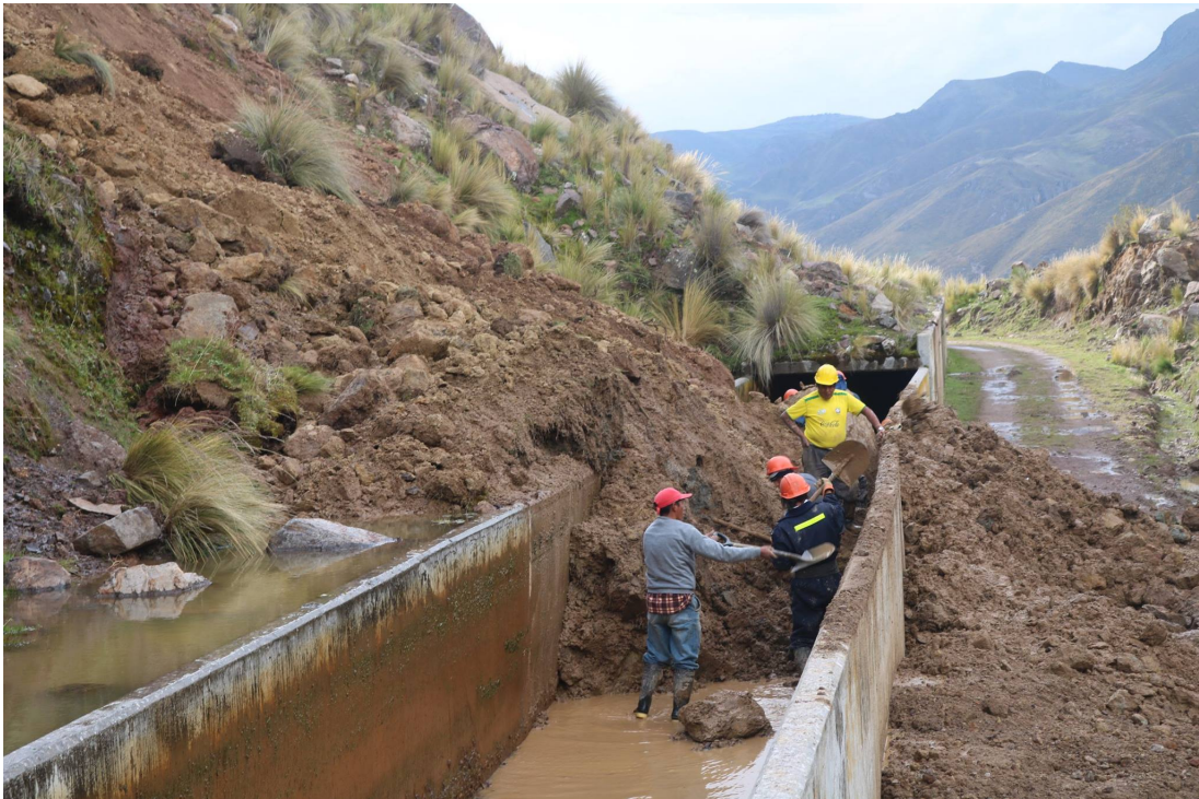
Figura A.2: Limpieza del canal
