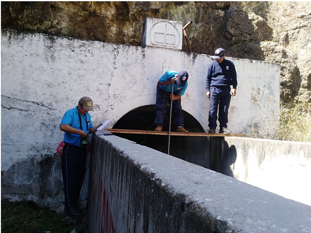
Figura A.12: Aforo en la entrada del túnel
