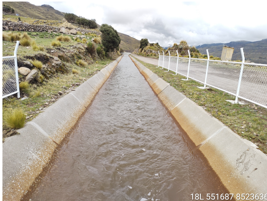
Figura 3.7: Canal principal, Proyecto Especial Río Cachi
