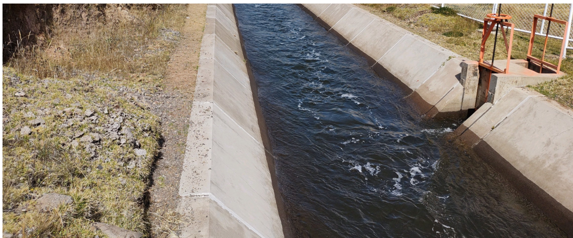
Figura 4.60: Estación hidrométrica en el canal de salida de la presa Cuchoquesera
