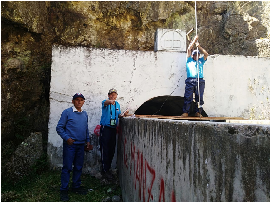
Figura A.14: Aforo en la entrada del túnel
