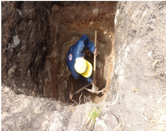
(a) Estudio de suelo (calicata)
