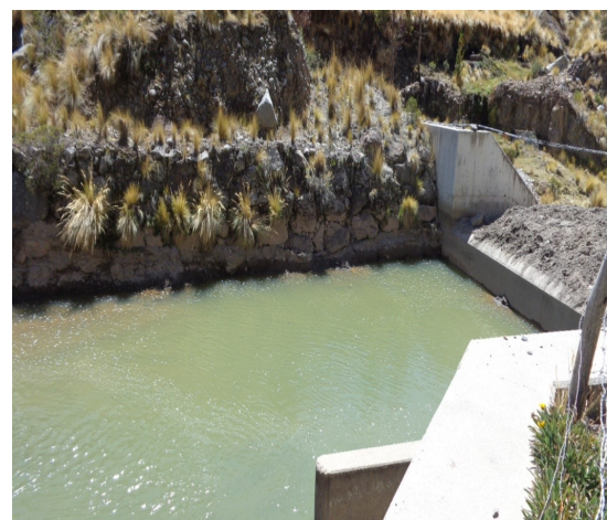
(b) Descolmatación de estructuras hidráulicas (bocatomas)
