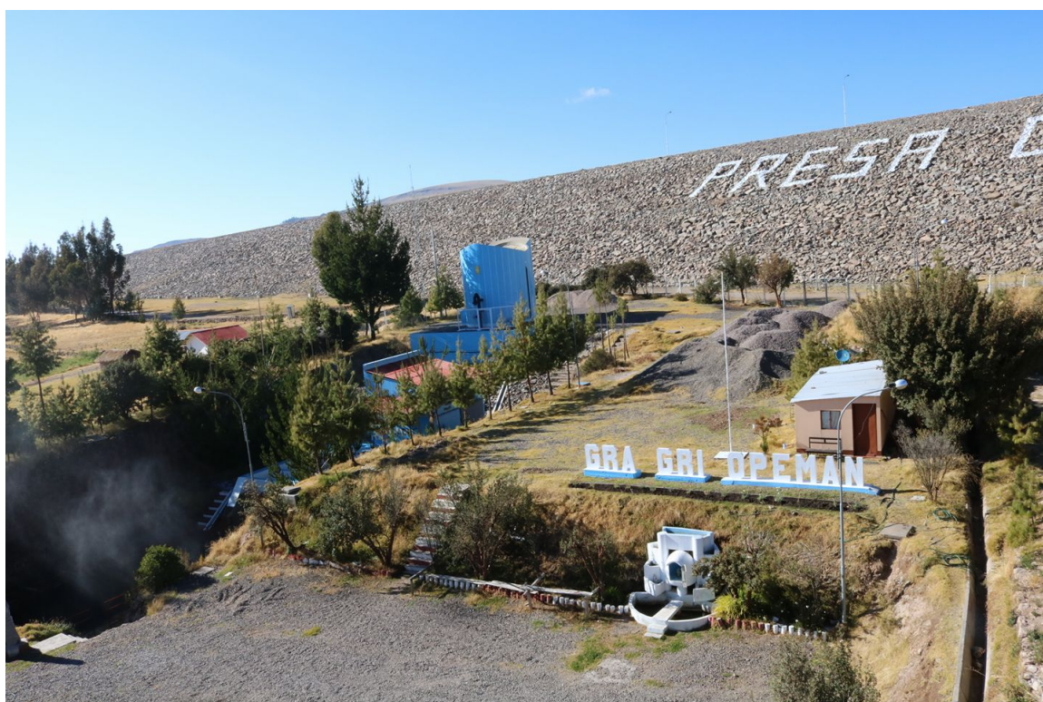
Figura A.1: Canal de salida de la Presa Cuchoquesera
