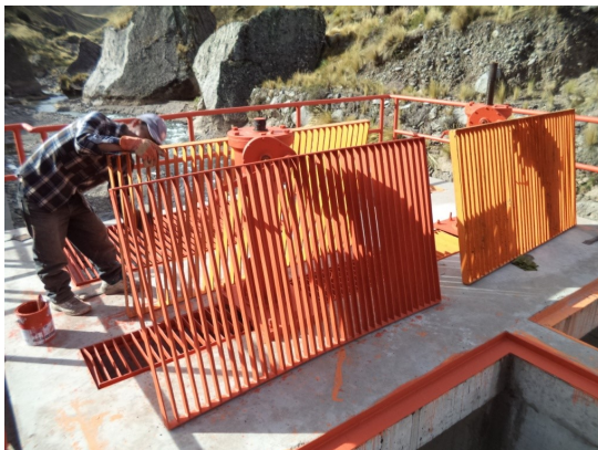
(a) Mejoramiento de bocatomas
