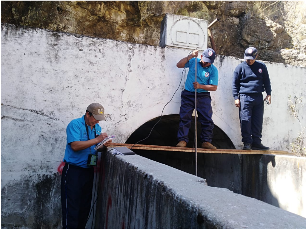
Figura A.13: Aforo en la entrada del túnel
