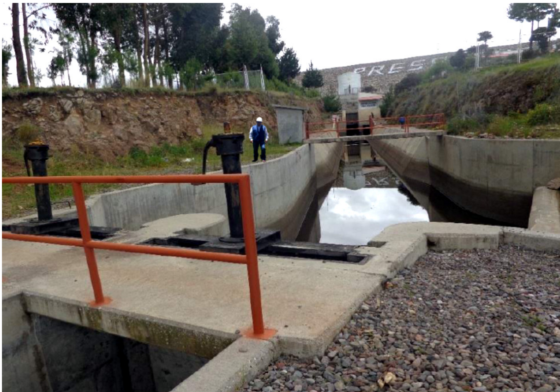
Figura A.6: Verificando las estructuras hidráulicas
