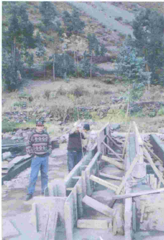
Fotog. 2 Inicio de los trabajos de infraestructura piscícola. Se observa la construcción de los estanques de alevinaje donde se realizará la siembra de los alevinos.
