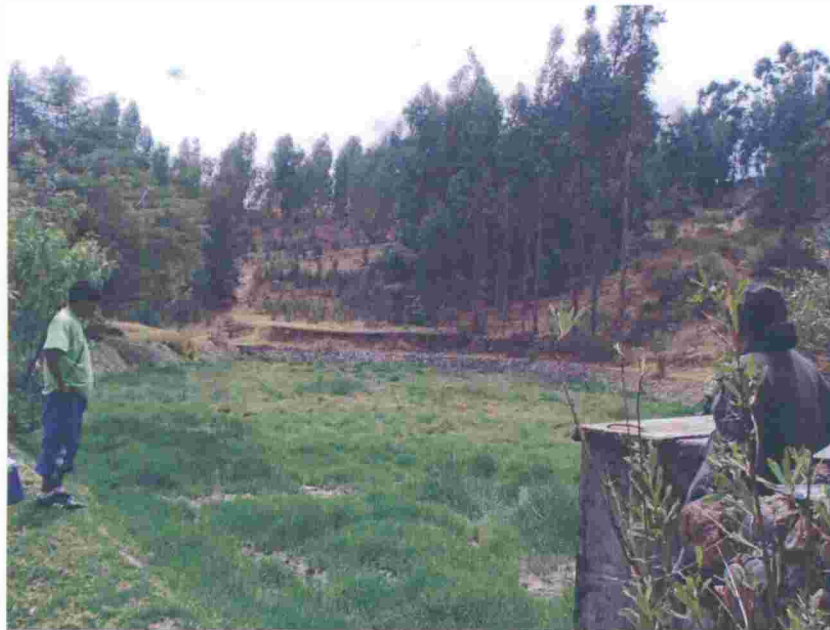
Fotografía N° 09: Laguna de Oxidación del distrito de Quinua. Setiembre del 2011.
