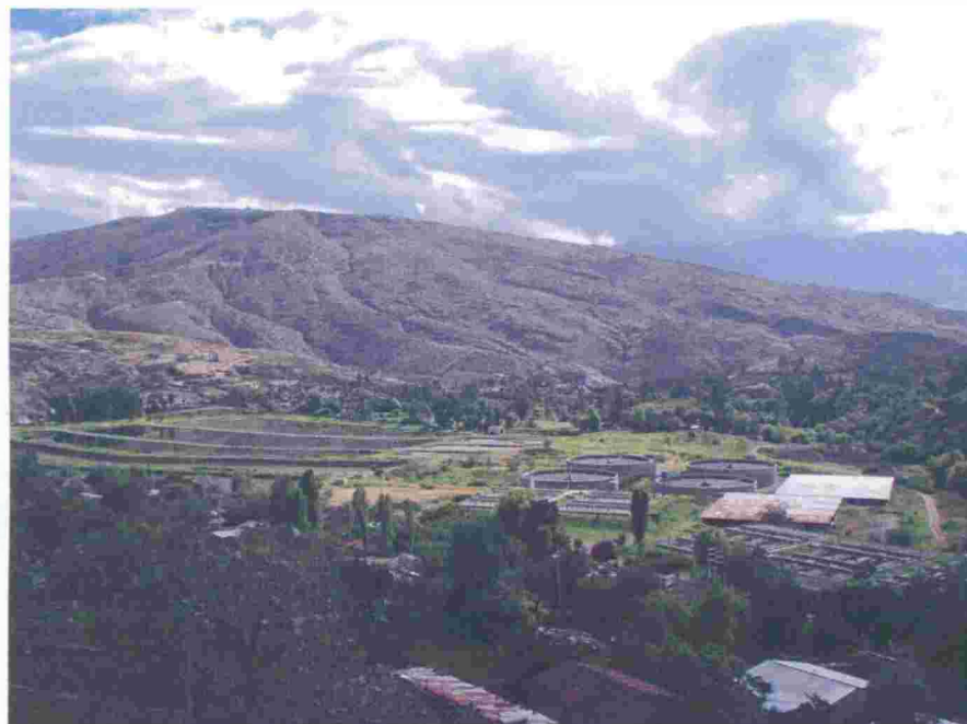
Fotografía N°10: PTAR del distrito de Jesús Nazareno "La Titora". Enero del 2012.
