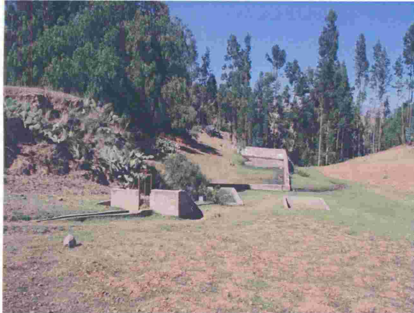
Fotografía N° 07: Planta de Tratamiento de Aguas Residuales del distrito de Acosvinchos. Setiembre del 2011.
