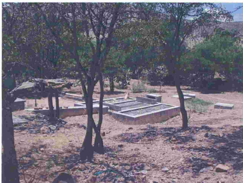
Fotografía N° 02: Tanques de sedimentación de la planta de aguas residuales del distrito de Pacaycasa – Huayllapampa. Noviembre de 2011.
