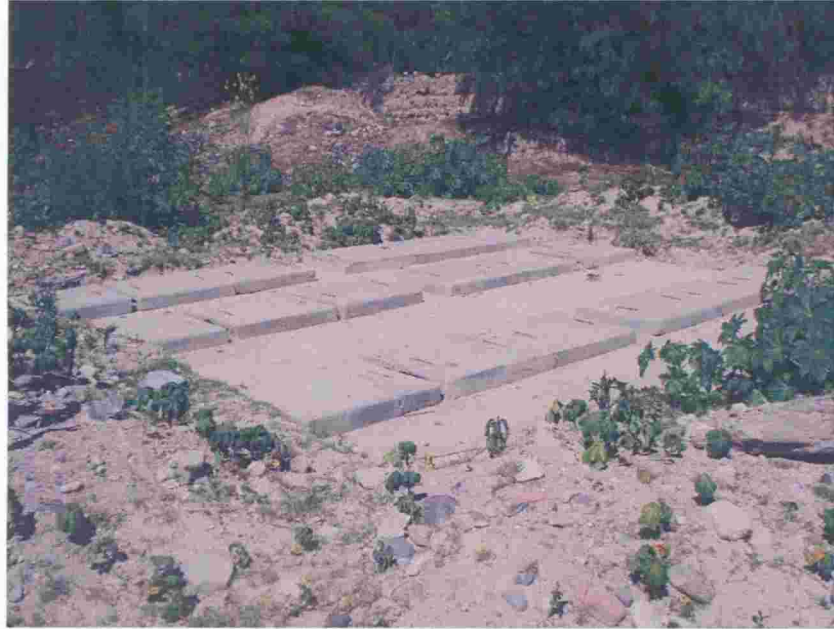
Fotografía N° 03: Pozos sépticos del distrito de Pacaycasa-Orcasitas. Noviembre de 2011.
