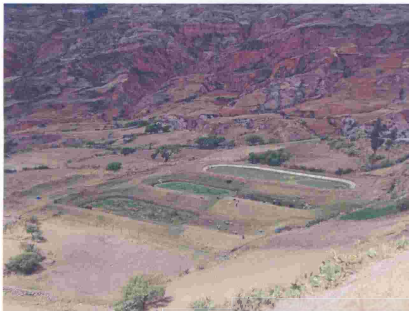
Fotografía N° 01: Lagunas de Oxidación del Distrito de Socos. Setiembre del 2011.
