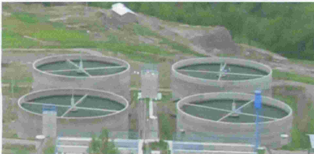
Fotografía 05. Biofiltros de la planta de tratamiento de aguas residuales "La Totorá"- Ayacucho
