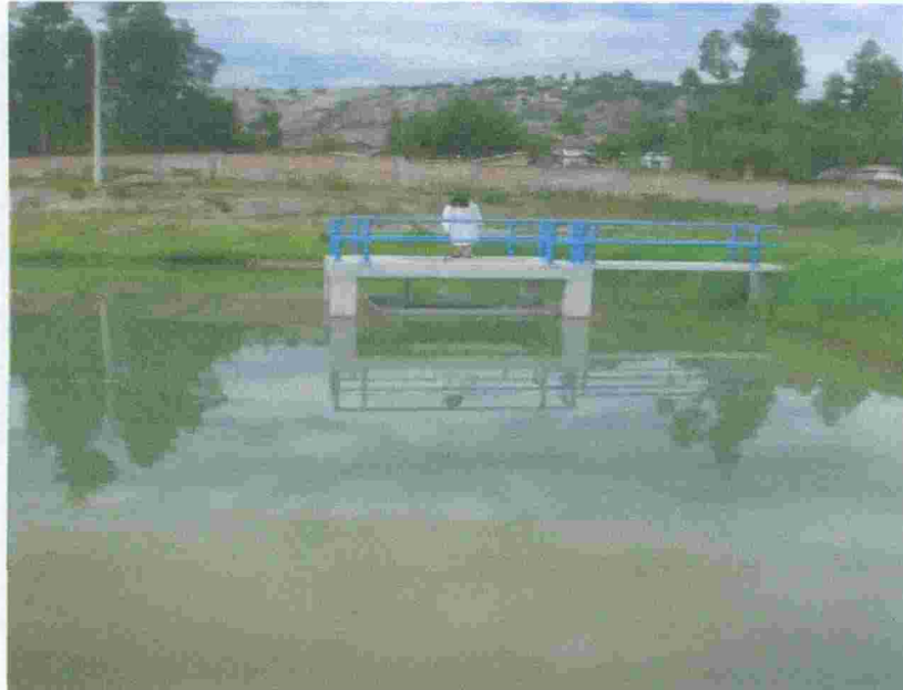
Fotografía 03: Laguna facultativa 1 de la planta de tratamiento de aguas residuales “La Totora”- Ayacucho
