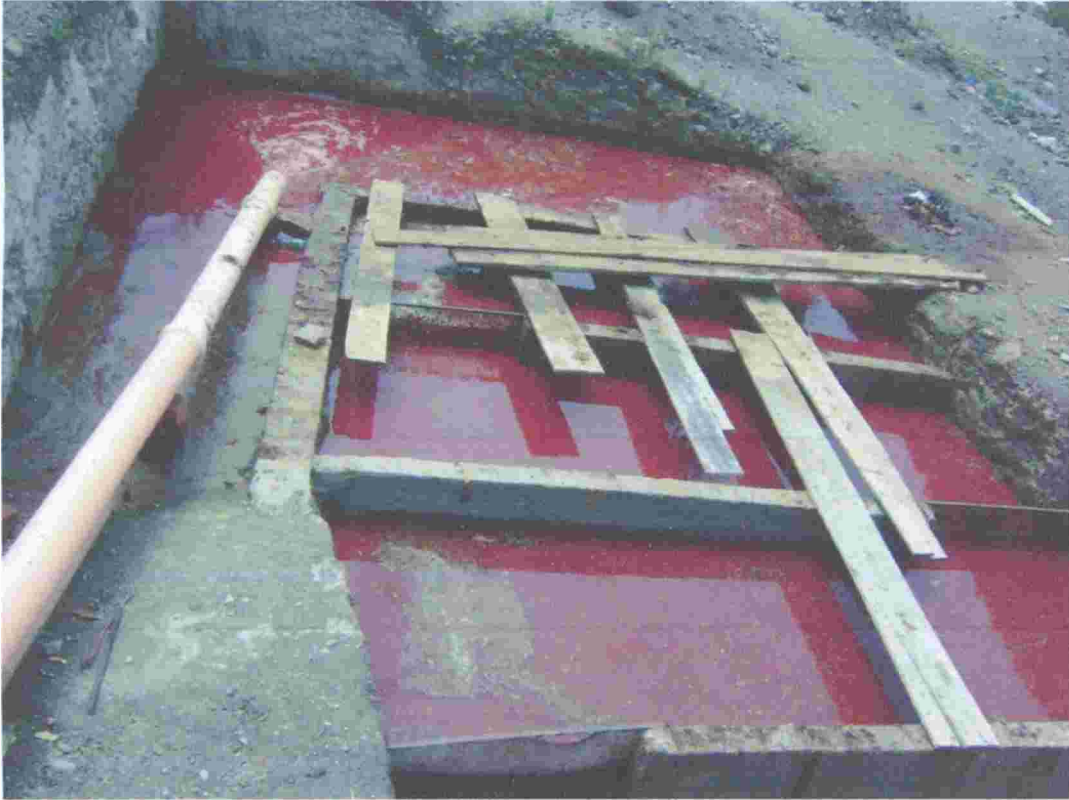
Fotografía N° 04: Sistema de rejado artesanal como parte del proceso físico de separación de desechos sólidos de gran tamaño. Camal Quicapata. Ayacucho 2011 - 2012.
