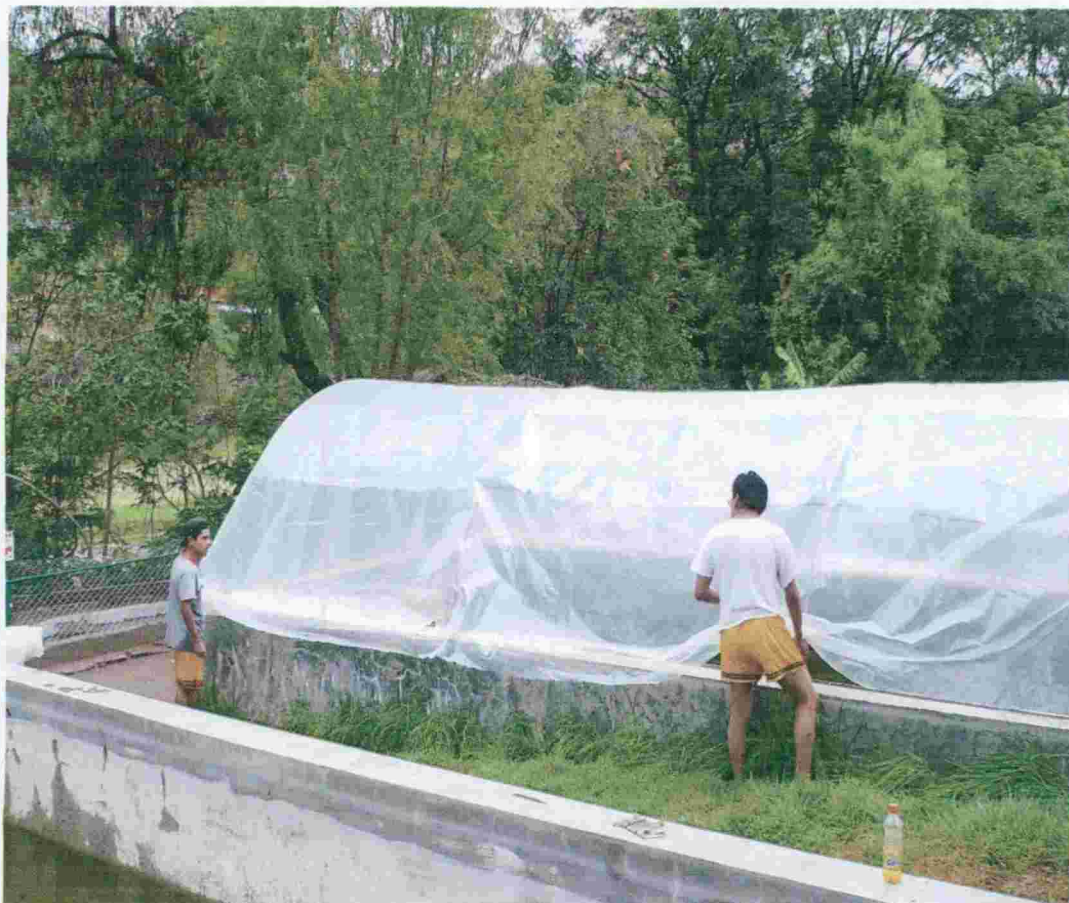
Fotografía N° 01: Cobertura del almacén del invernadero con el plástico transparente en el Centro Ecológico Recreacional y Experimental “La Totorilla”, del 11 de enero al 04 de abril. Ayacucho, 2009.
