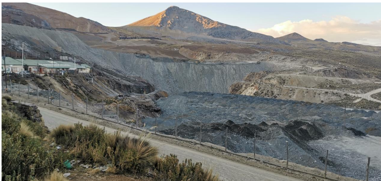
Figura 52. Relleno del tajo desde febrero hasta el 30 de julio 2019 (cota 4586 msnm).
