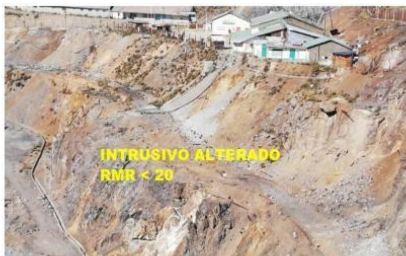
Figura 40. Celdas de Mapeo Geomecánico 06: Intrusivo alterado con óxidos de limo.
