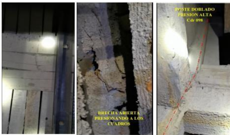
Figura 30. Brecha abierta presionando a los cuadros (cuadros 097 y 098).
