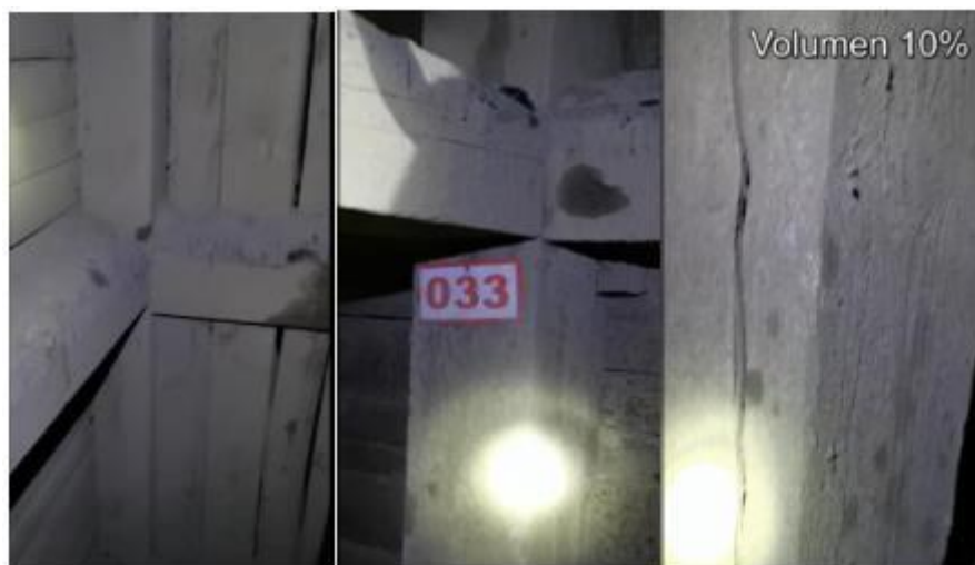
Figura 25. No se observa deformación tampoco deterioro de los cuadros del pique.
