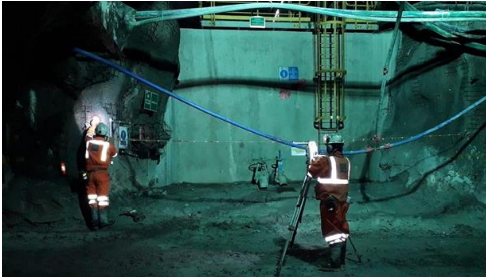
Figura 13: Medición de deformación en Estación de bombeo Nv. 11
