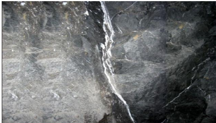
Figura 15. El material que se encuentra relleno dentro de la discontinuidad
