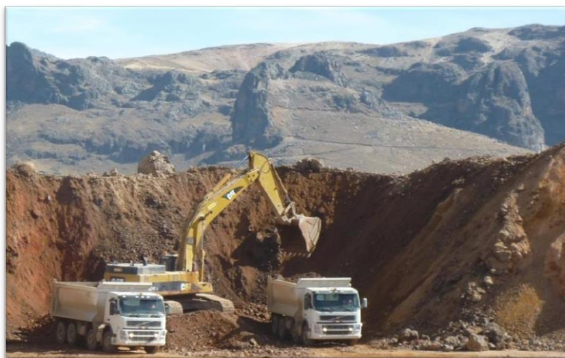
Figura 14. Equipo de carguío Excavadora CAT 345
