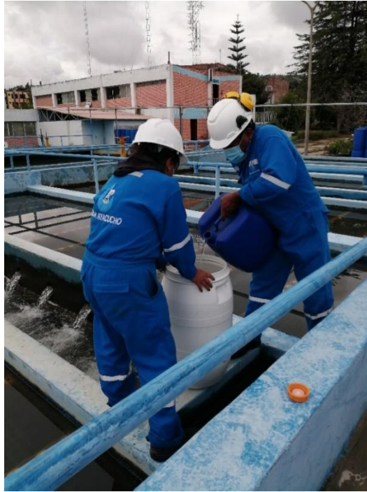
Figura C3. Fotografía del vaciado del peróxido de hidrógeno al bidón dosificador por parte de los operarios de la PTAP – Quicapata.
